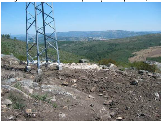
Fotografia 147 - Local de implantação do apoio 78 com reposição da topografia.
