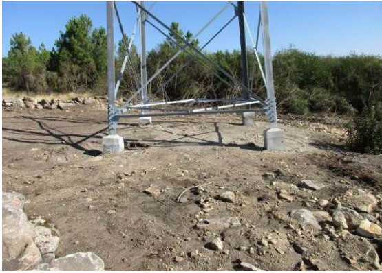
Fotografia 57 - Local de implantação do apoio 30 descompactado.
