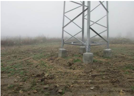
Fotografia 3 - Local de implantação do apoio 1A com a reposição da topografia.
