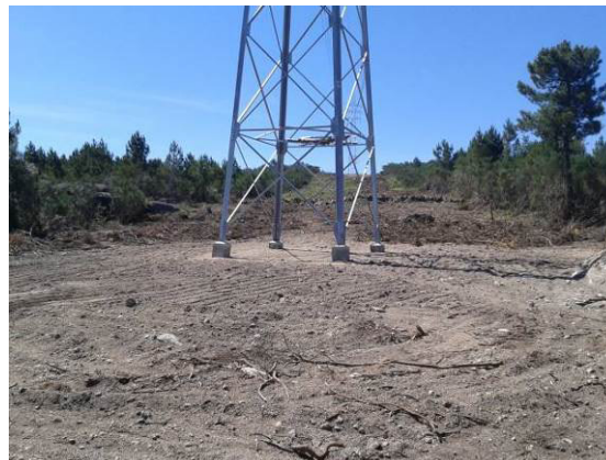
Fotografia 130 - Local de implantação do apoio 69.
