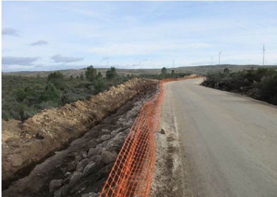
Fotografia 42 - Vala de cabos aberta no acesso para o aerogerador AG10.
