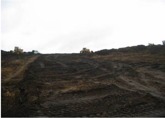
Fotografia 1 - Decapagem do local de implantação da Subestação.
