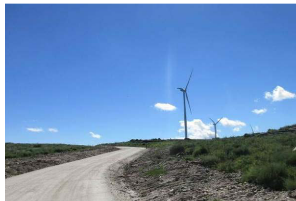
Fotografia 51 - Valeta de drenagem em terreno natural na via B.
