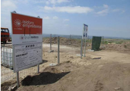
Fotografia 56 - Área de estaleiro devidamente vedada e identificada.
