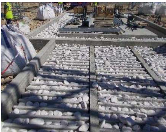
Fotografia 13 - Colocação de gravilha na bacia do transformador.
