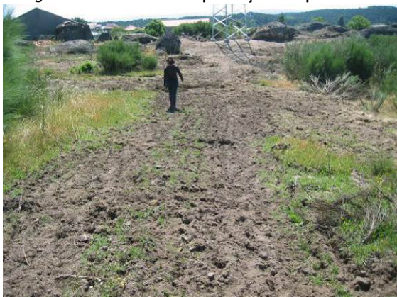
Fotografia 129 - Acesso ao local de implantação do apoio 68 descompactado.
