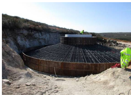
Fotografia 60 - Montagem da armadura na fundação do aerogerador AG28.
