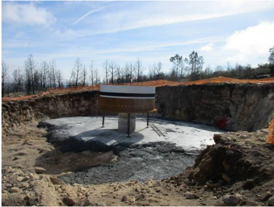
Fotografia 1 - Cabouco da fundação do aerogerador AG01 com betão de limpeza e anel montado.
