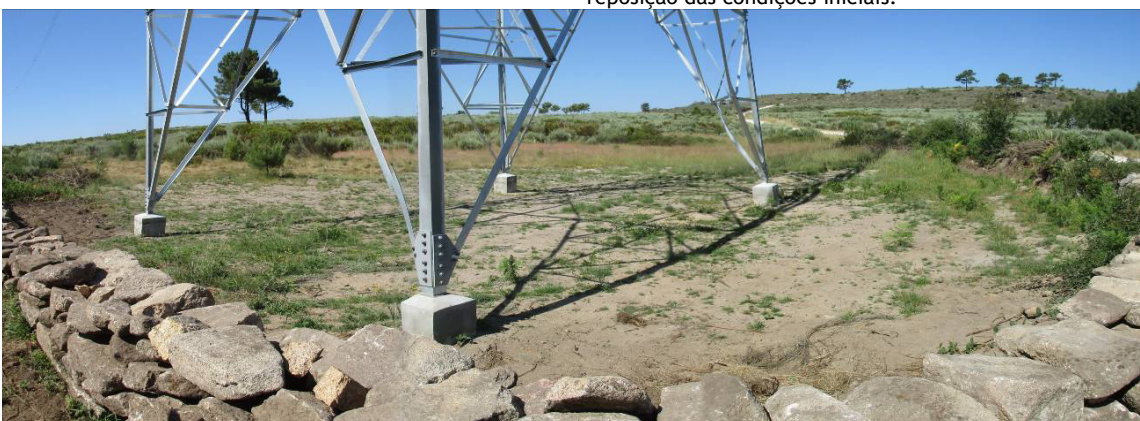
Fotografia 37 - Área de implantação do apoio 20 após a reposição das condições iniciais.
