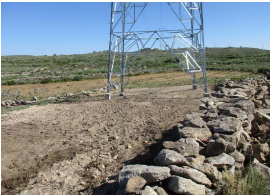
Fotografia 33 - Área de implantação do apoio 17 após a reposição das condições iniciais.
