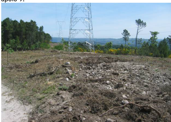
Fotografia 20 - Área de implantação do apoio 10 após a reposição das condições iniciais.
