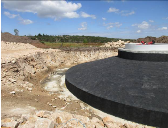
Fotografia 31 - Sapata do aerogerador AG14 impermeabilizada.
