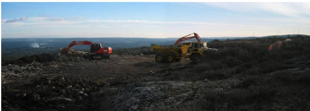
Fotografia 57 - Abertura do cabouco da fundação e construção da plataforma do aerogerador AG27.
