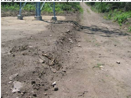
Fotografia 152 - Local de implantação do apoio 81.
