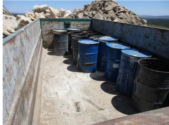
Fotografia 160 - Contentor para armazenamento temporário de resíduos de embalagens contaminadas.
