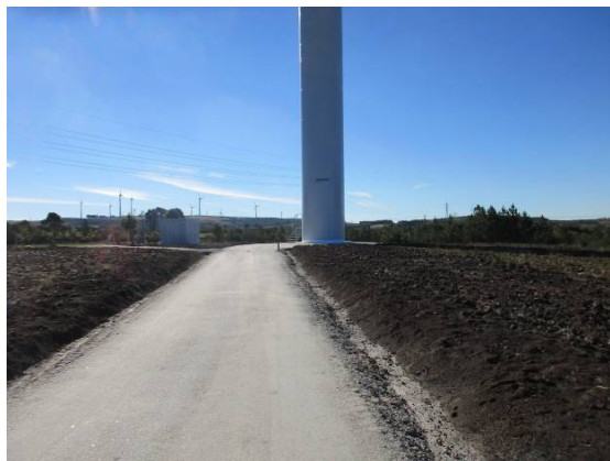
Fotografia 166 - Valeta de drenagem em terreno natural no acesso ao aerogerador AG05.
