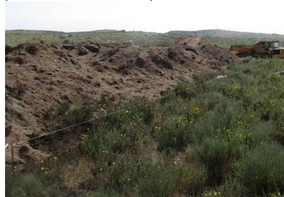
Fotografia 59 - Balizagem da área de intervenção do aerogerador AG08.
