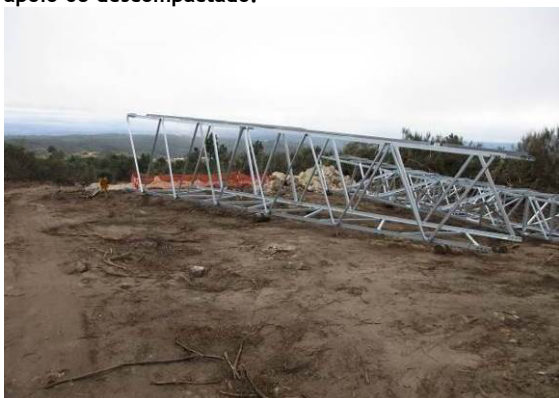
Fotografia 131 - Assemblagem do apoio 70.
