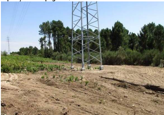
Fotografia 115 - Local de implantação do apoio 61 descompactado.
