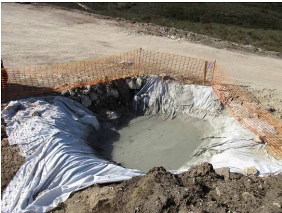
Fotografia 157 - Bacia para lavagem das caleiras das autobetoneiras na área de implantação do aerogerador AG28.
