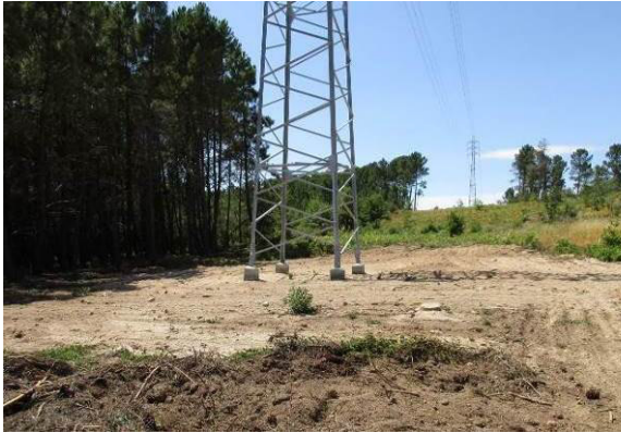
Fotografia 113 - Local de implantação do apoio 60 com reposição da topografia.
