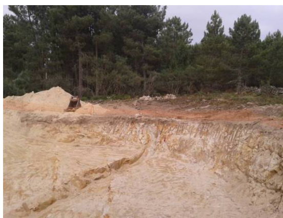
Fotografia 93 - Cabouco da fundação do aerogerador AG40.
