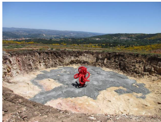
Fotografia 80 - Cabouco da fundação do aerogerador AG35.
