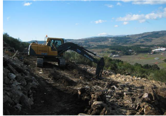
Fotografia 79 - Abertura dos caboucos da fundação do apoio 46.
