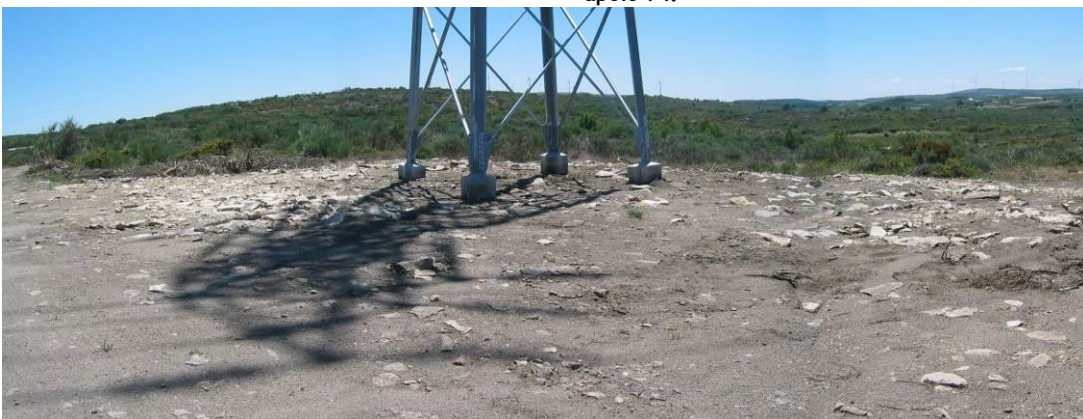
Fotografia 174 - Local de implantação do apoio 94 com reposição da topografia.
