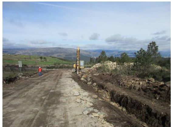
Fotografia 117 - Escavação da vala de cabos entre os aerogeradores AG01 e AG02.
