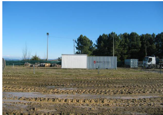
Fotografia 92 - Parque de materiais e contentor de ferramentaria no estaleiro de Armamar.
