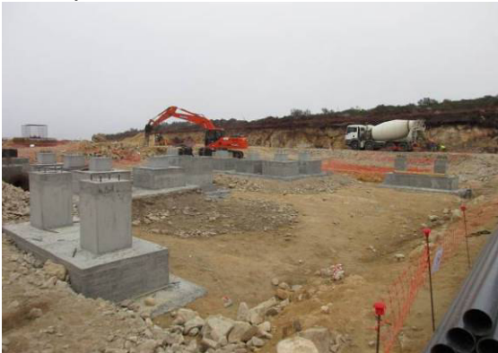
Fotografia 3 - Aterro das fundações da Subestação.
