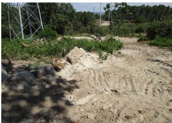
Fotografia 103 - Acesso ao apoio 54-B descompactado e muro de pedra seca reconstruído.
