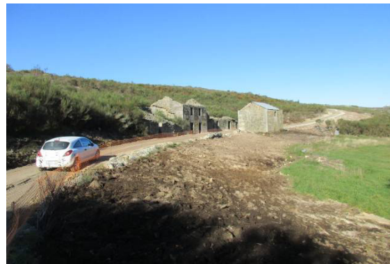
Fotografia 149 - Balizagem da área de intervenção e ocorrências patrimoniais na via L6.
