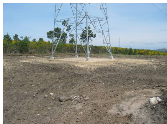
Fotografia 16 - Área de implantação do apoio 7 após a reposição das condições iniciais.
