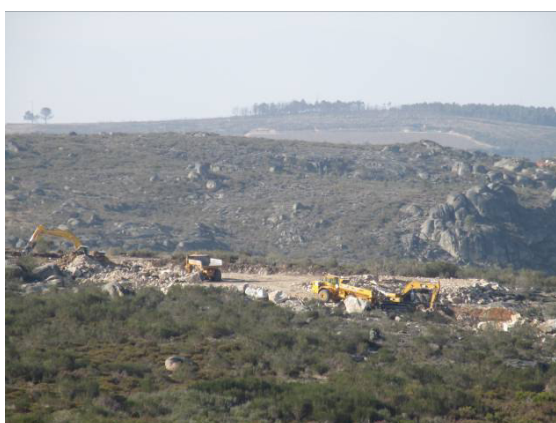
Fotografia 49 - Área de implantação do aerogerador AG23 durante os trabalhos de escavação do cabeço da fundação e construção da plataforma.
