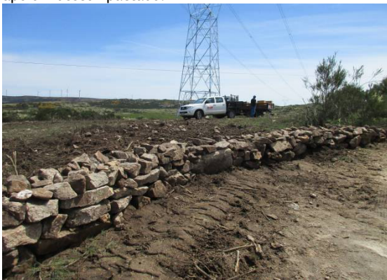
Fotografia 11 - Muro reconstruído e acesso ao apoio 5 descompactado.
