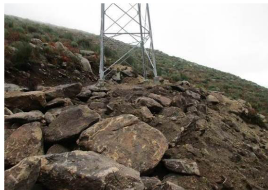
Fotografia 14 - Local de implantação do apoio 5 com reposição da topografia.
