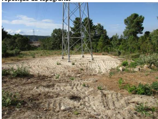
Fotografia 88 - Local de implantação do apoio 48 com reposição da topografia.
