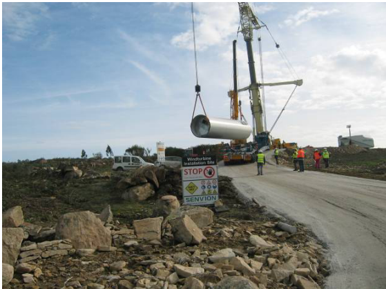
Fotografia 14 - Montagem mecânica do aerogerador AG07.
