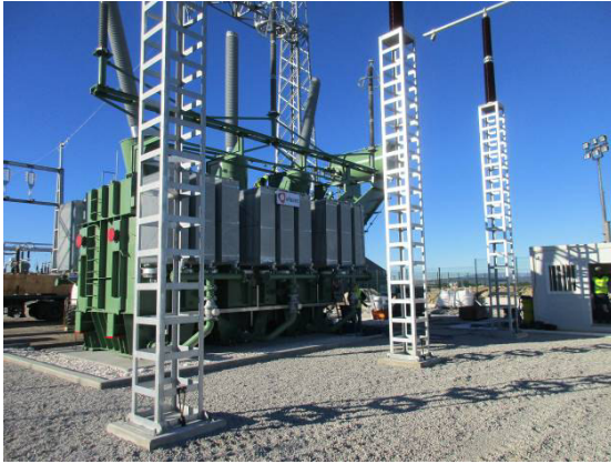
Fotografia 17 - Montagem de transformador de 400 kV na Subestação.
