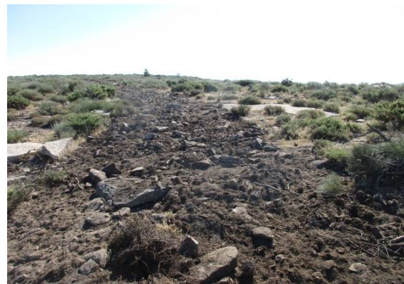
Fotografia 31 - Acesso ao apoio 16 descompactado.
