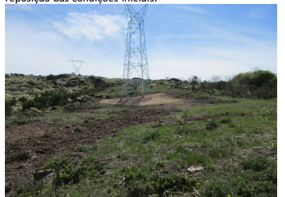
Fotografia 8 - Área de implantação do apoio 4 após a reposição das condições iniciais.
