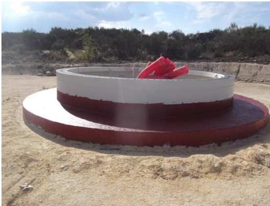
Fotografia 33 - Fundação do do aerogerador AG15 aterrada.
