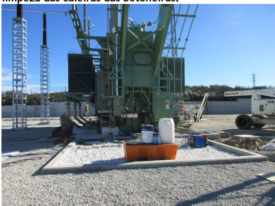
Fotografia 45 - Substâncias poluentes na frente de trabalhos da Subestação, colocadas sobre uma bacia de retenção.
