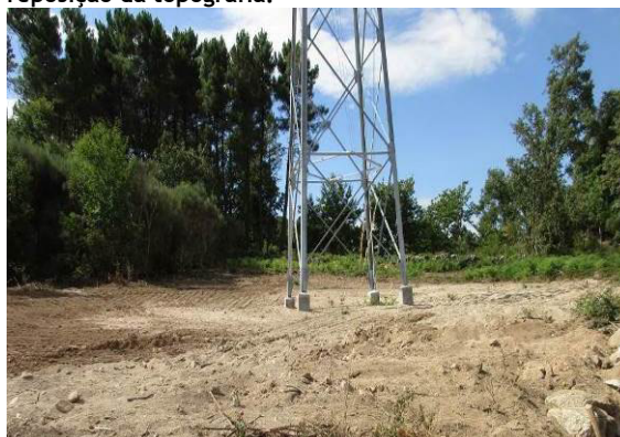
Fotografia 84 - Local de implantação do apoio 46 onde foi realizada a reposição da topografia.
