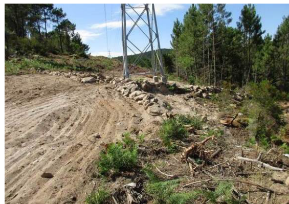
Fotografia 96 - Acesso ao apoio 52 descompactado e muros de pedra seca reconstruídos.
