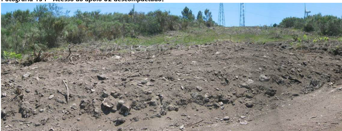
Fotografia 155 - Acesso ao apoio 82-A descompactado.
