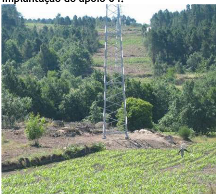
Fotografia 123 - Local de implantação do apoio 64 depois de implementadas as medidas de recuperação.
