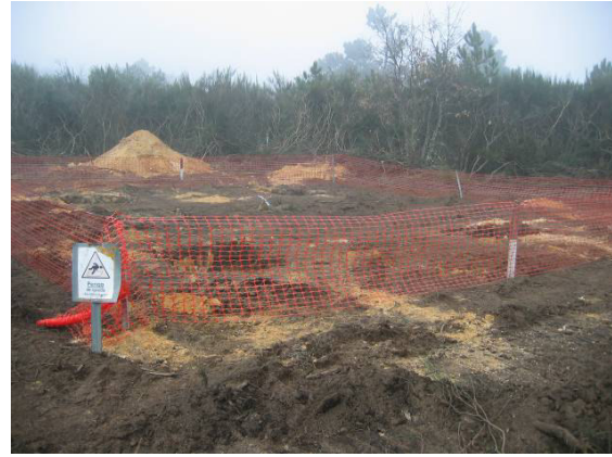
Fotografia 105 - Materiais de escavação do cabouco dos apoios 1 (a) e 7 (b) armazenados em pargas e respetivas áreas de intervenção balizadas.
