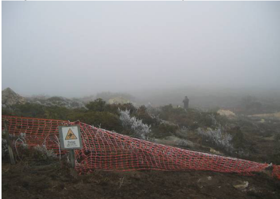
Fotografia 100 - Balizagem da área de intervenção e sinalização de obra.
