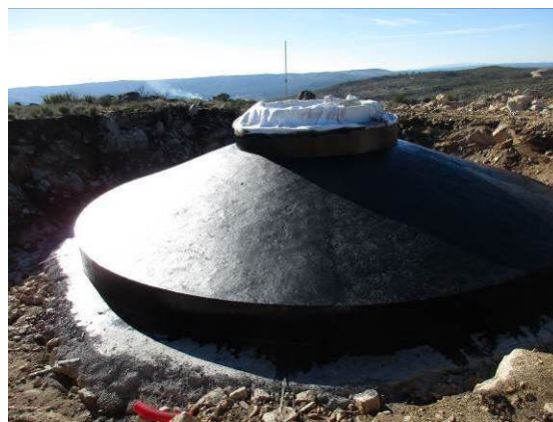
Fotografia 8 - Fundação do aerogerador AG03 betonada e impermeabilizada.
