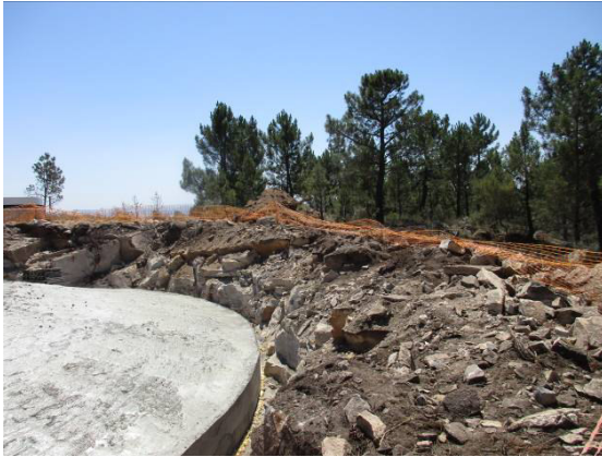
Fotografia 85 - Fundação do aerogerador AG37 betonada e área de intervenção balizada.
