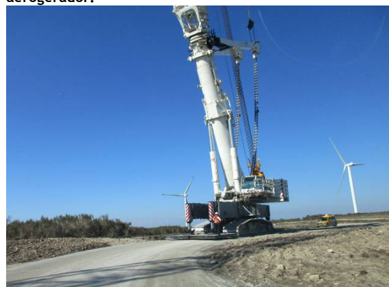
Fotografia 164 - Deslocação da grua de montagem mecânica no percurso entre os aerogeradores AG25 e AG26.
