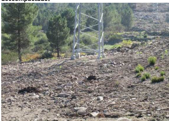
Fotografia 55 - Local de implantação do apoio 29 com reposição da topografia.
