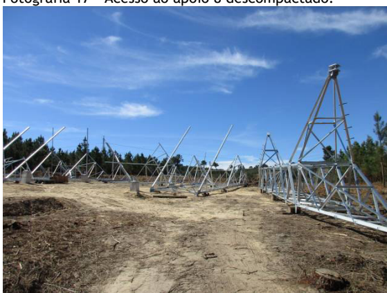
Fotografia 18 - Assemblagem da estrutura metálica do apoio 9.
