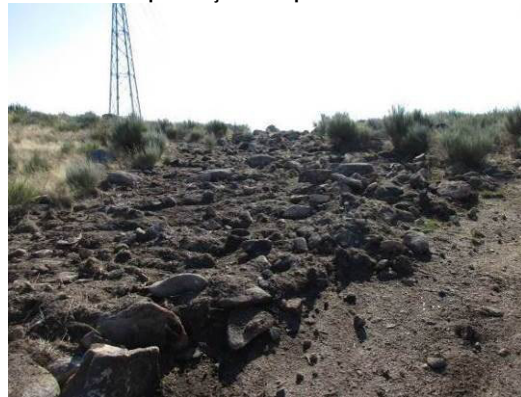
Fotografia 60 - Acesso ao apoio 31 descompactado.
