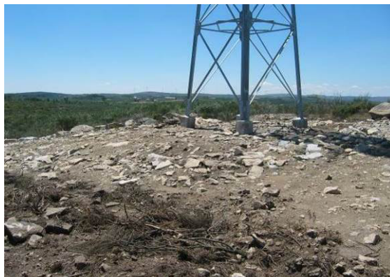
Fotografia 176 - Local de implantação do apoio 95 com reposição da topografia.
