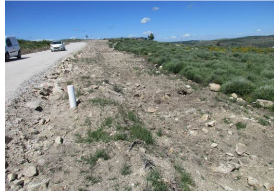
Fotografia 43 - Vala de cabos terminada na via B.
