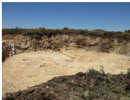
Fotografia 83 - Cabouco da fundação do aerogerador AG36.
