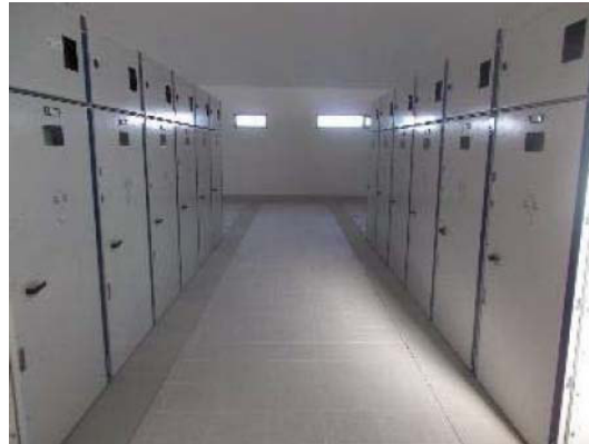
Fotografia 28 - Interior do Edifício de Comando.
