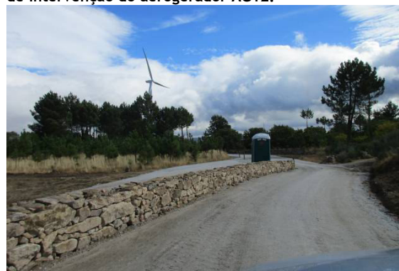
Fotografia 153 - Muro de pedra seca reconstruído na via N1.
