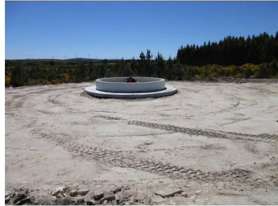
Fotografia 10 - Fundação do aerogerador AG05 aterrada.
