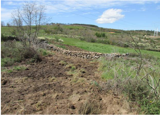
Fotografia 9 - Muro de pedra reconstruído e acesso ao apoio 4 descompactado.
