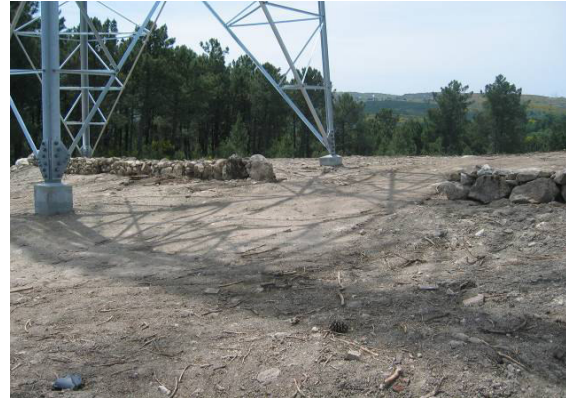
Fotografia 25 - Área de implantação do apoio 12 após a reposição das condições iniciais e muro de pedra seca reconstruído.
