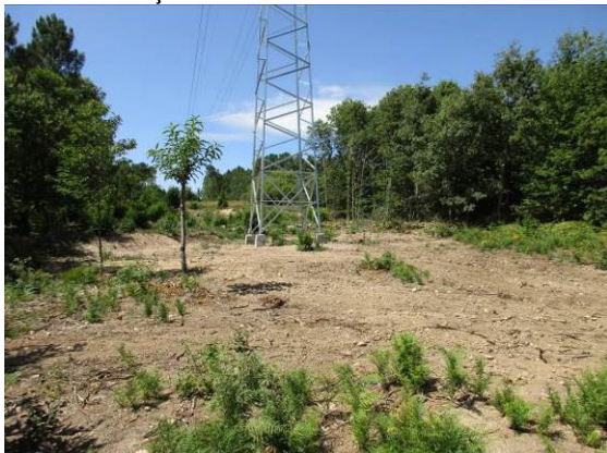
Fotografia 198 - Exemplar jovem de castanheiro preservado no corredor da Linha a 60 kV junto ao apoio 58.
