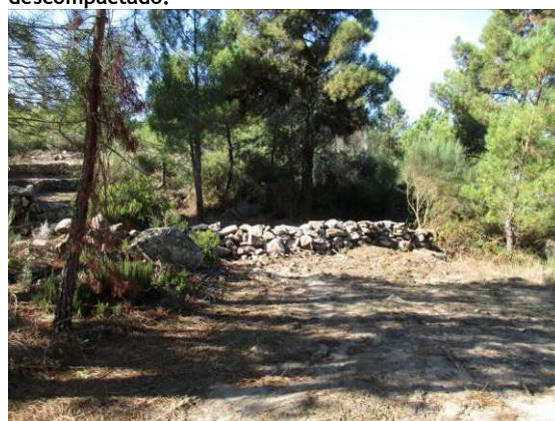
Fotografia 52 - Acesso ao apoio 27 descompactado e muros de pedra seca reconstruídos.
