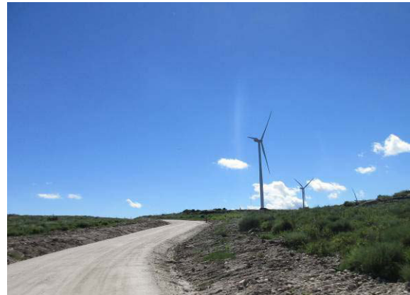
Fotografia 41 - Acesso existente entre os aerogeradores AG07 e AG08 no final da obra.
