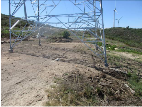
Fotografia 72 - Área de implantação do apoio 41 após a reposição das condições iniciais.
