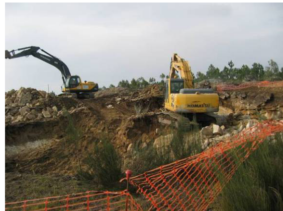
Fotografia 22 - Escavação do cabouco da fundação do aerogerador AG10.
