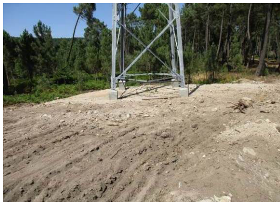
Fotografia 98 - Local de implantação do apoio 54 com reposição da topografia.
