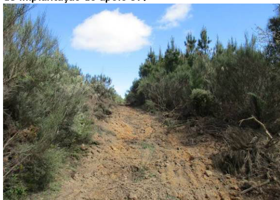
Fotografia 72 - Acesso ao apoio 39 descompactado.
