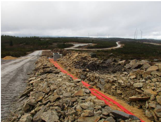
Fotografia 129 - Execução da junção de cabos na vala ao longo da via L8, entre os aerogeradores AG24 e AG25.
