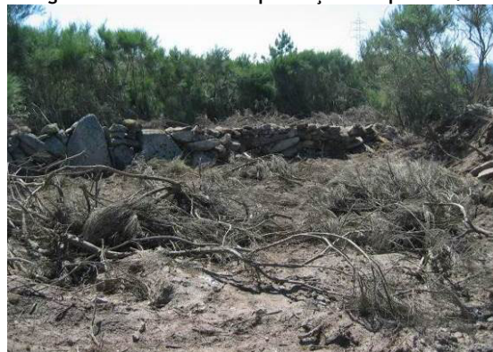
Fotografia 134 - Muro de pedra seca reconstruído no acesso ao apoio 70.
