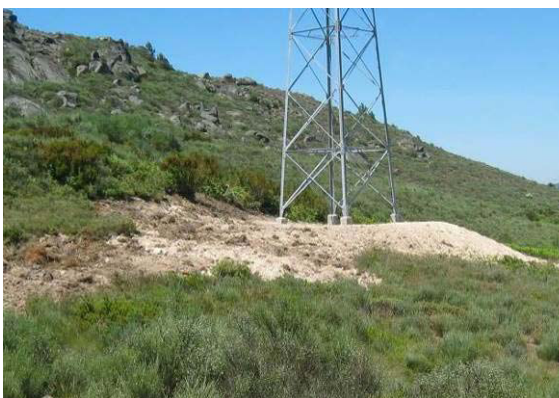
Fotografia 166 - Local de implantação do apoio 90 com reposição da topografia.
