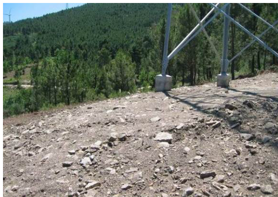
Fotografia 161 - Local de implantação do apoio 87 com reposição da topografia.
