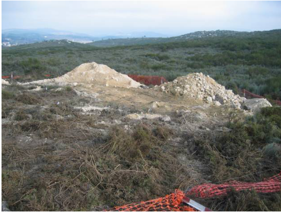
Fotografia 105 - Materiais de escavação do cabouco dos apoios 1 (a) e 7 (b) armazenados em pargas e respetivas áreas de intervenção balizadas.
