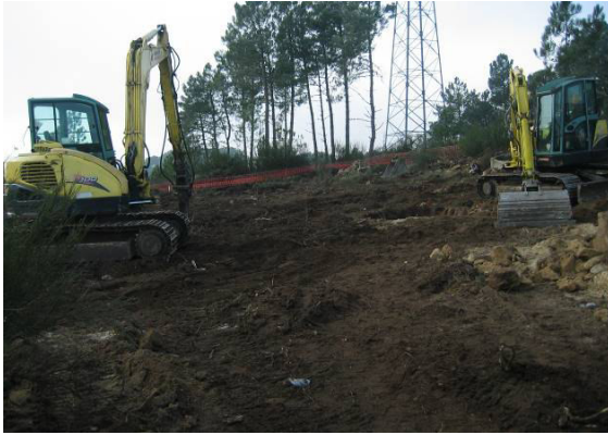
Fotografia 24 - Abertura dos caboucos da fundação do apoio 12.
