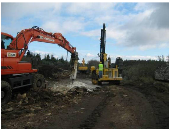
Fotografia 27 - Escavação do cabouco da fundação do aerogerador AG12.
