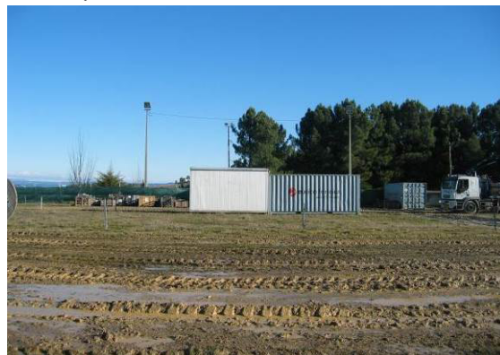
Fotografia 189 - Parque de materiais e contentor de ferramentaria no estaleiro de Armamar.
