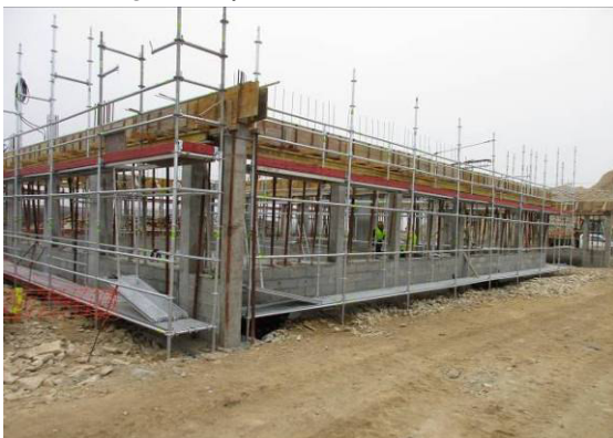
Fotografia 25 - Trabalhos de construção do Edifício de Comando.
