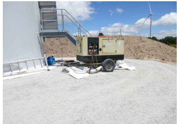
Fotografia 163 - Trabalhos de comissionamento de um aerogerador.
