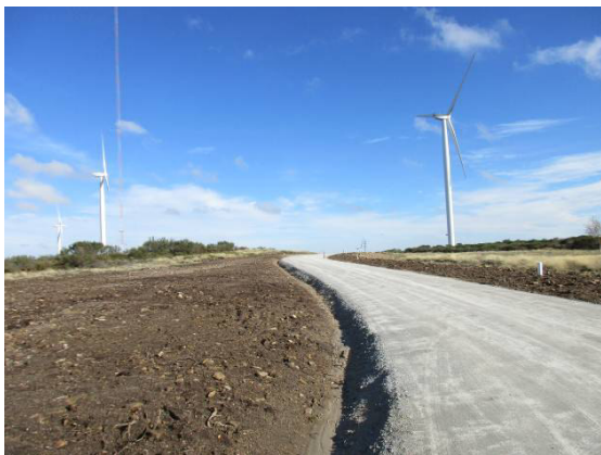
Fotografia 165 - Valeta de drenagem em terreno natural na via L7.
