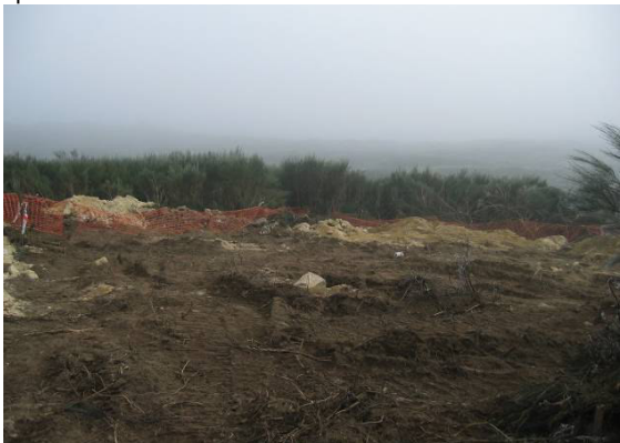
Fotografia 3 - Abertura dos caboucos da fundação do apoio 2.
