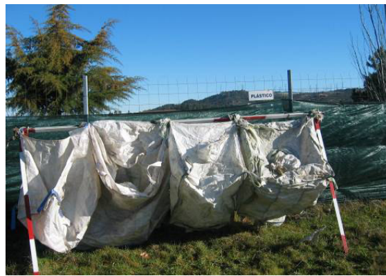
Fotografia 94 - Área para depósito temporário de resíduos no estaleiro de Armamar.
