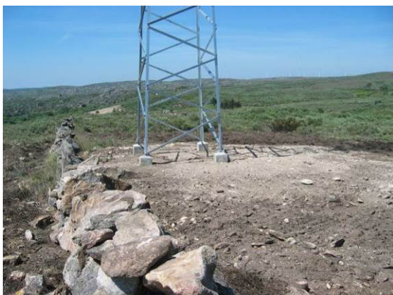
Fotografia 137 - Local de implantação do apoio 72 e muro de pedra seca reconstruído.
