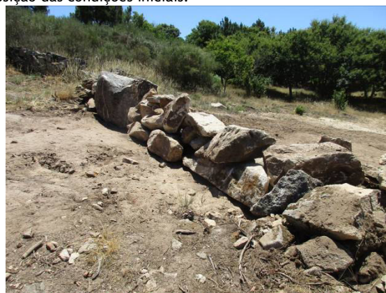
Fotografia 61 - Muro de pedra reconstruído junto da área de intervenção do apoio 35.
