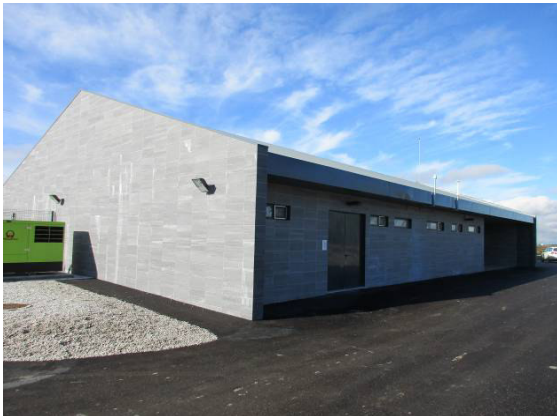
Fotografia 33 - Edifício de Comando concluído.
