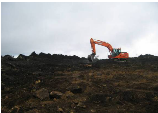
Fotografia 23 - Decapagem do local de implantação do Edifício de Comando.
