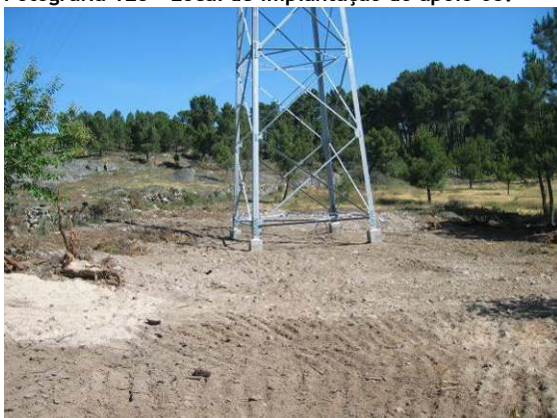
Fotografia 126 - Solo descompactado no local de implantação do apoio 66.
