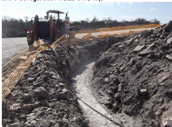
Fotografia 124 - Desenrolamento de cabos na vala entre os aerogeradores AG25 e AG26.
