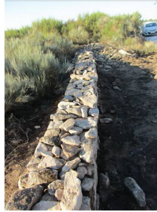
Fotografia 154 - Muro de pedra seca reconstruído na proximidade do aerogerador AG19.
