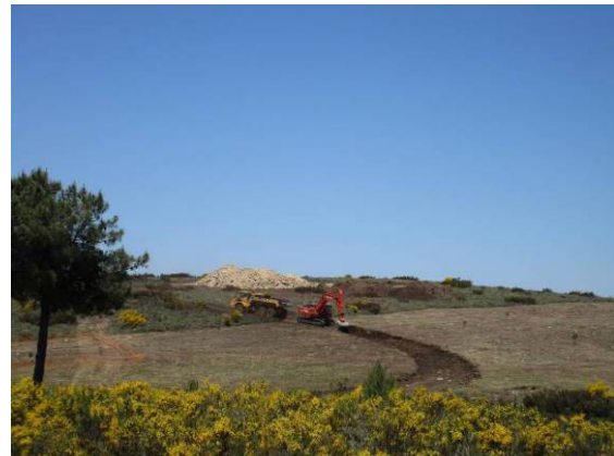
Fotografia 102 - Decapagem da via L9 para acesso ao aerogerador AG36.
