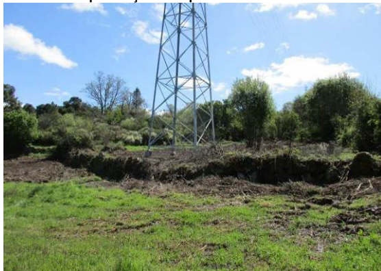
Fotografia 69 - Muro de pedra seca reconstruído junto ao local de implantação do apoio 36.
