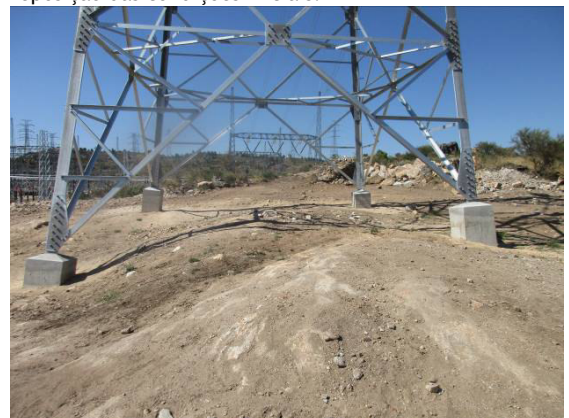
Fotografia 85 - Área de implantação do apoio 48 após a reposição das condições iniciais.
