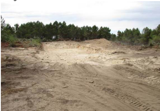
Fotografia 33 - Área de implantação do aerogerador AG12 decapada.
