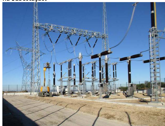
Fotografia 14 - Montagem de equipamentos de 400 kV na Subestação.
