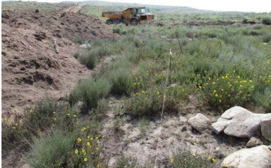
Fotografia 22 - Decapagem da área de implantação do aerogerador AG08.
