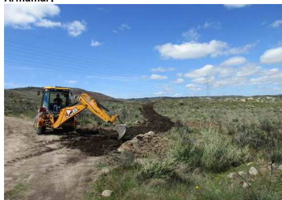
Fotografia 195 - Balizagem para evitar a afetação do marco geodésico próximo da área de implantação do apoio 93.
