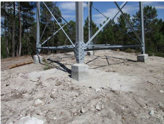
Fotografia 93 - Local de implantação do apoio 51 descompactado.
