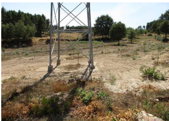
Fotografia 105 - Local de implantação do apoio 56 descompactado.
