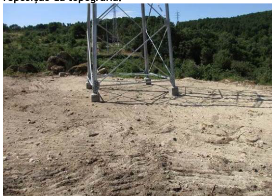
Fotografia 100 - Local de implantação do apoio 54-A descompactado.
