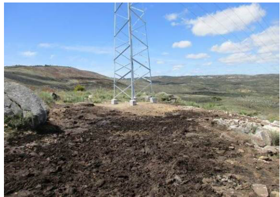
Fotografia 62 - Local de implantação do apoio 32 onde foi realizada a reposição da topografia.
