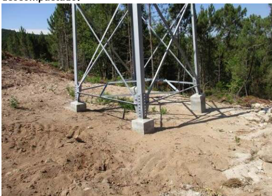
Fotografia 95 - Local de implantação do apoio 52 descompactado.
