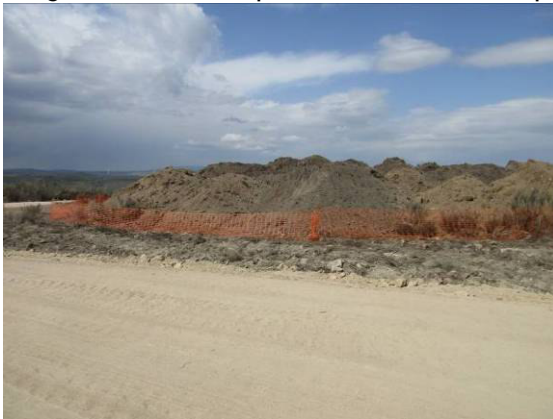
Fotografia 155 - Depósito de terra vegetal localizado na bifurcação da via L7 com a via L1.
