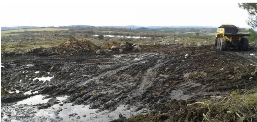
Fotografia 29 - Trabalhos de decapagem da área de implantação do aerogerador AG13.
