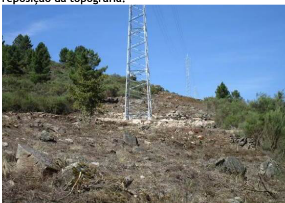
Fotografia 43 - Local de implantação do apoio 21 com reposição da topografia.
