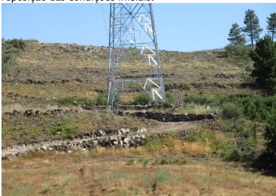
Fotografia 30 - Área de implantação do apoio 15 após a reposição das condições iniciais.
