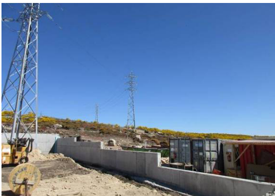
Fotografia 7 - Muro que limita a área da Subestação e Linha Elétrica Aérea a 60 kV de Sernancelhe.
