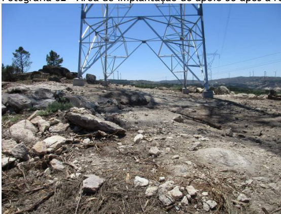
Fotografia 63 - Área de implantação do apoio 36 após a reposição das condições iniciais.
