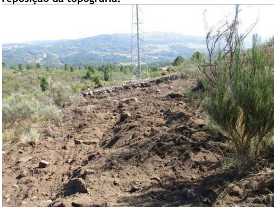
Fotografia 45 - Acesso ao apoio 22 descompactado e muros de pedra seca reconstruídos.
