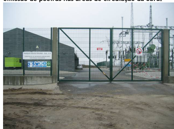
Fotografia 46 - Entrada da Subestação após a conclusão das obras.
