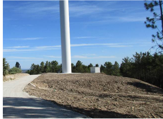
Fotografia 86 - Área de implantação do aerogerador AG37 e área envolvente após a recuperação paisagística.
