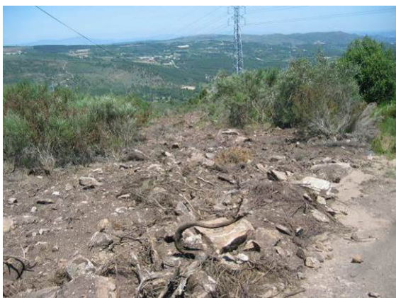
Fotografia 154 - Acesso ao apoio 82 descompactado.
