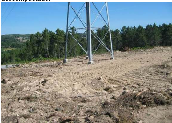
Fotografia 117 - Local de implantação do apoio 62 com a reposição da topografia.
