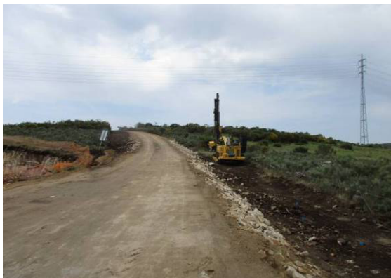
Fotografia 118 - Abertura da vala de cabos junto ao local de implantação do aerogerador AG33.
