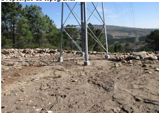
Fotografia 37 - Local de implantação do apoio 18 onde foi realizada a reposição da topografia e reconstruídos os muros de pedra seca.
