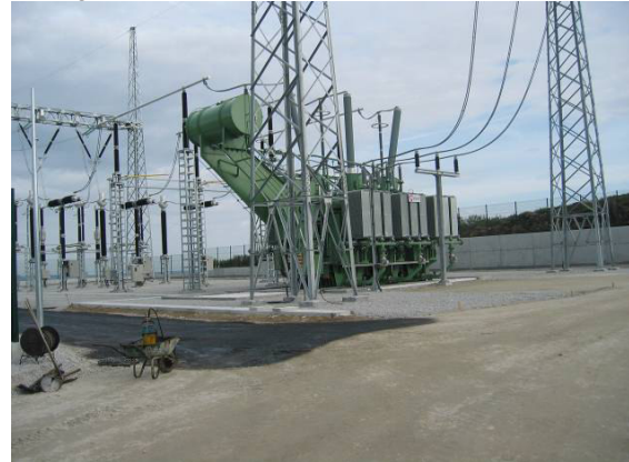
Fotografia 18 - Área de 60 kV com brita e rede de drenagem.
