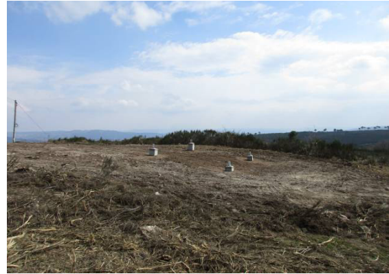
Fotografia 10 - Fundação do apoio 5 aterrada.
