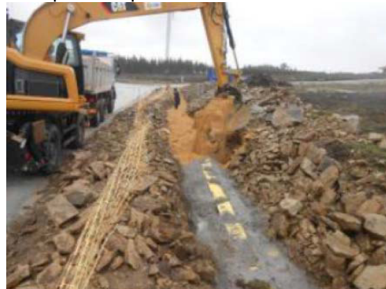
Fotografia 128 - Aterro da vala de cabos.
