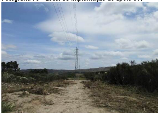
Fotografia 75 - Trabalhos de desenrolamento dos cabos na área do apoio 41.
