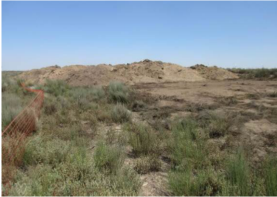
Fotografia 52 - Exemplo de parga de terra vegetal proveniente da decapagem do terreno na via A
