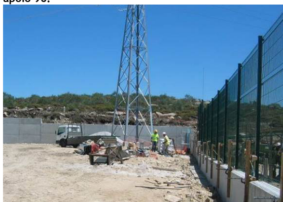
Fotografia 182 - Local de implantação do apoio 97 no interior da Subestação de Moimenta.
