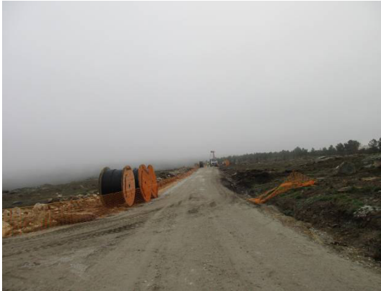
Fotografia 125 - Desenrolamento de cabos ao longo da via de acesso ao aerogerador AG14.
