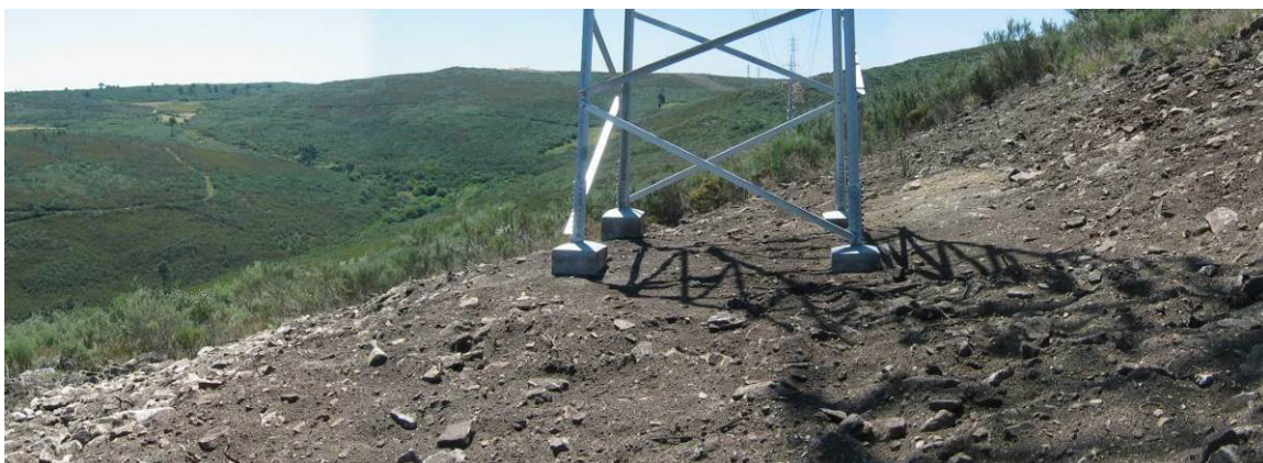
Fotografia 149 - Local de implantação do apoio 79 com reposição da topografia.
