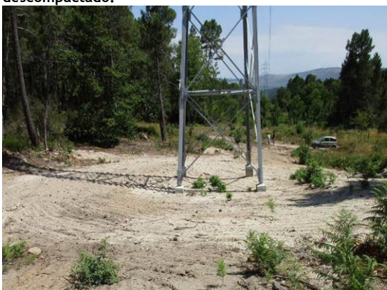
Fotografia 111 - Local de implantação do apoio 59 com reposição da topografia.
