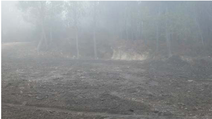
Fotografia 144 - Área de apoio aos trabalhos no núcleo da Aldeia de Nacomba após a implementação das medidas de recuperação paisagística realizada no final da obra.
