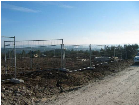
Fotografia 131 - Trabalhos iniciais de montagem da área de estaleiro.
