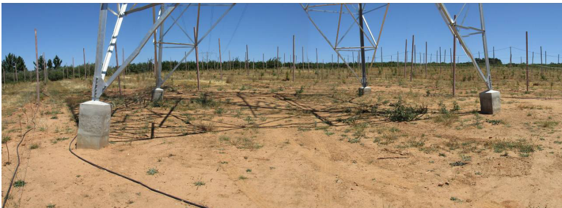
Fotografia 59 - Área de implantação do apoio 33 após a reposição das condições iniciais.
