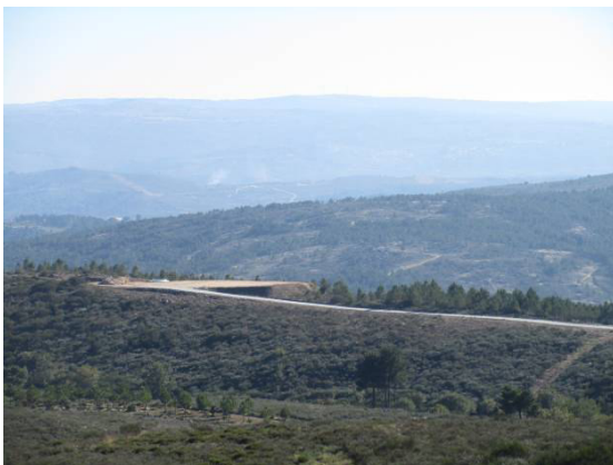
Fotografia 45 - Vista geral da área de implantação do aerogerador AG21.
