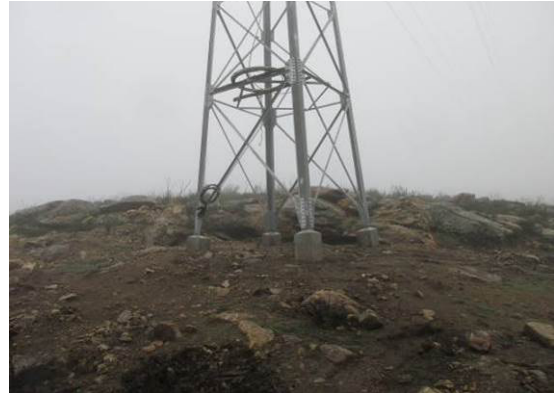
Fotografia 2 - Local de implantação do apoio 1 onde foi realizada a descompactação do solo e modelação do terreno.
