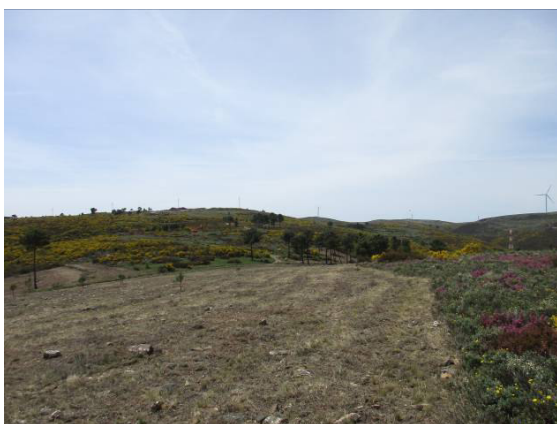
Fotografia 82 - Área de implantação do aerogerador AG36 antes do início dos trabalhos.
