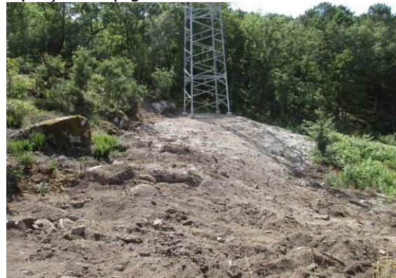
Fotografia 92 - Local de implantação do apoio 50 e acesso descompactado.
