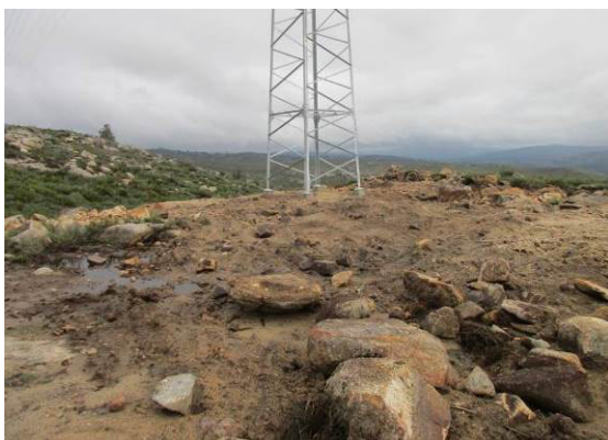
Fotografia 25 - Local de implantação do apoio 11 com reposição da topografia.
