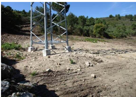
Fotografia 41 - Local de implantação do apoio 20 com reposição da topografia.
