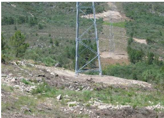
Fotografia 160 - Local de implantação do apoio 86.
