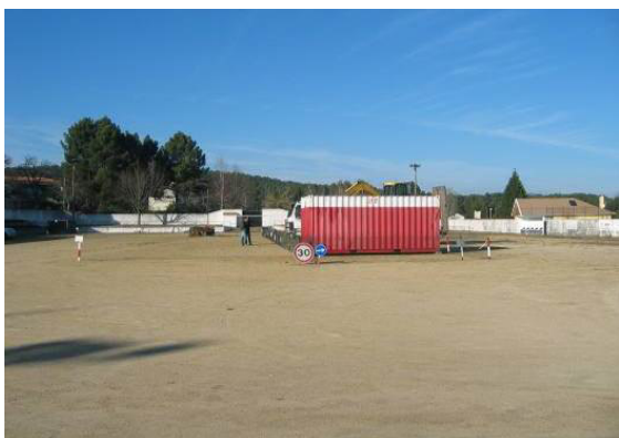
Fotografia 184 - Parque de materiais e contentor de ferramentaria no estaleiro de Leomil.
