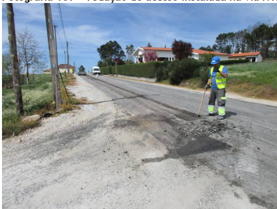
Fotografia 170 - Trabalhos de reparação do pavimento da EM529 após a execução da vala de cabos entre os aerogeradores AG04 e AG06.
