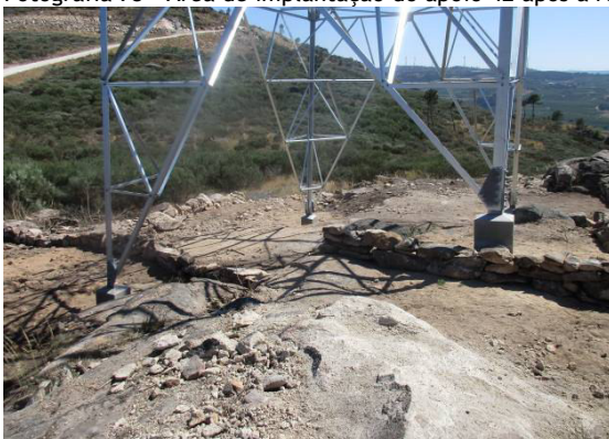
Fotografia 74 - Área de implantação do apoio 43 após a reposição das condições iniciais.
