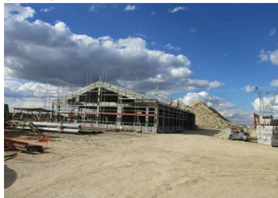
Fotografia 26 - Trabalhos de construção do Edifício de Comando.
