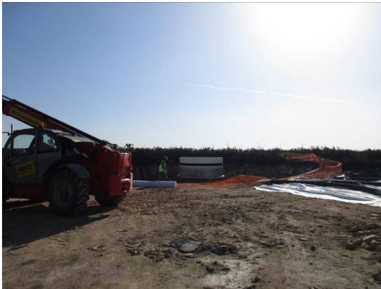
Fotografia 53 - Instalação do anel de fundação do aerogerador AG25.
