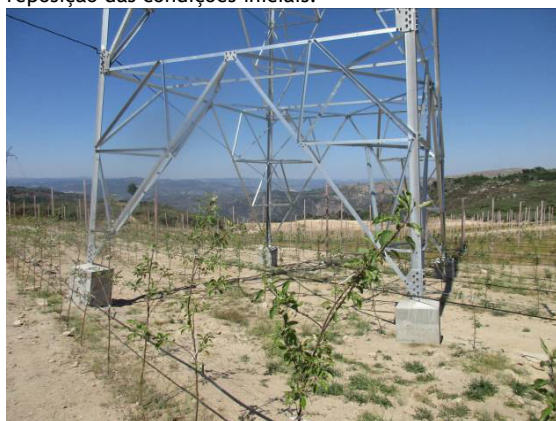
Fotografia 71 - Área de implantação do apoio 40 após a reposição das condições iniciais.
