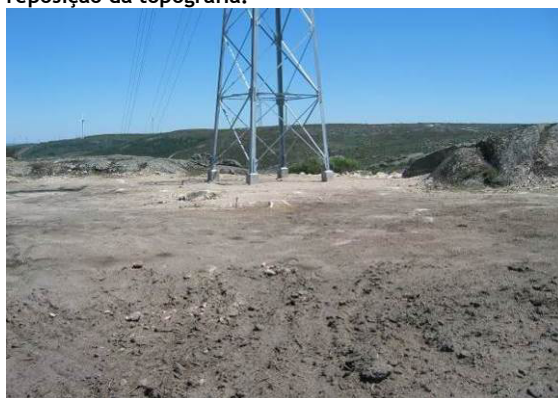
Fotografia 167 - Local de implantação do apoio 91.
