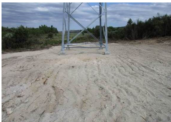
Fotografia 79 - Local de implantação do apoio 43 onde foi realizada a reposição da topografia.
