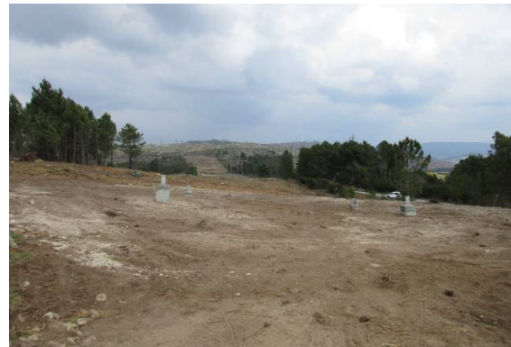
Fotografia 27 - Fundação do apoio 14 aterrada.
