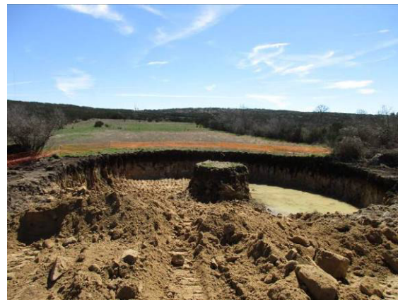
Fotografia 17 - Cabouco da fundação do aerogerador AG08.
