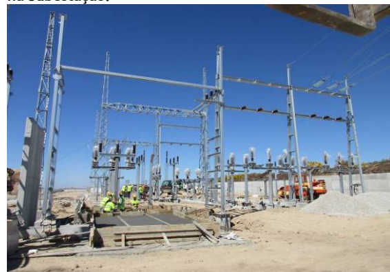
Fotografia 8 - Instalação de pórticos e equipamento.
