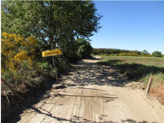
Fotografia 112 - Sinalética no acesso interrompido temporariamente durante os trabalhos de construção da vala de cabos entre o aerogerador AG06 e a estrada municipal EM529.
