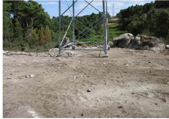
Fotografia 90 - Local de implantação do apoio 49 com reposição da topografia.
