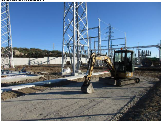
Fotografia 15 - Aterro da plataforma da Subestação.
