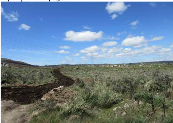
Fotografia 61 - Acesso ao apoio 32 descompactado.
