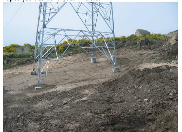
Fotografia 6 - Área de implantação do apoio 3 após a reposição das condições iniciais.
