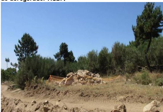
Fotografia 152 - Depósito temporários de pedras provenientes de muro na via N1.
