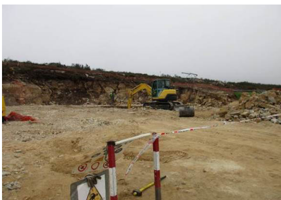
Fotografia 181 - Abertura do cabouco da fundação do apoio 97.
