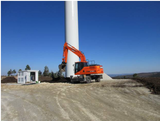
Fotografia 43 - Trabalhos de recuperação paisagística no aerogerador AG20.
