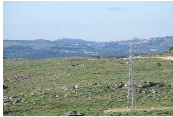
Fotografia 46 - Vista da área onde se encontrava instalado o estaleiro após a implementação das medidas de recuperação paisagística.
