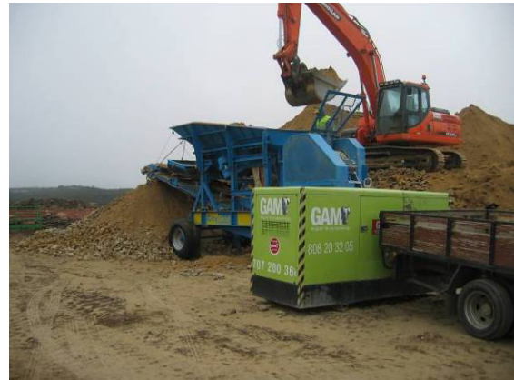
Fotografia 42 - Britadeira móvel na área de construção da Subestação. Os materiais britados foram usados nas atividades de construção do EC-SE.
