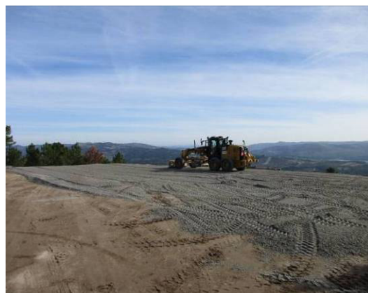
Fotografia 99 - Colocação de camada de tout-venant na plataforma do aerogerador AG42.
