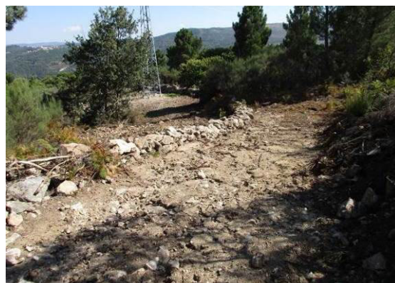
Fotografia 42 - Acesso ao apoio 20 descompactado e muros de pedra seca reconstruídos.
