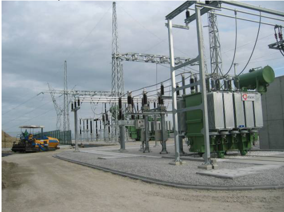
Fotografia 19 - Aplicação de betuminoso nas áreas de circulação.
