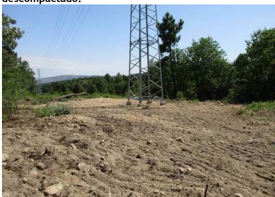
Fotografia 107 - Local de implantação do apoio 57 com reposição da topografia.
