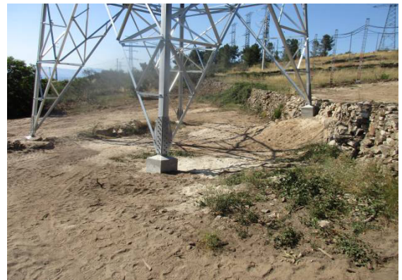
Fotografia 83 - Área de implantação do apoio 47 após reposição das condições iniciais.
