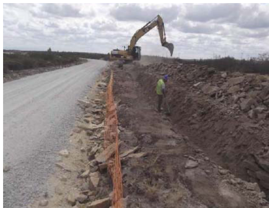
Fotografia 119 - Abertura da vala de cabos junto à área de implantação do aerogerador AG26.
