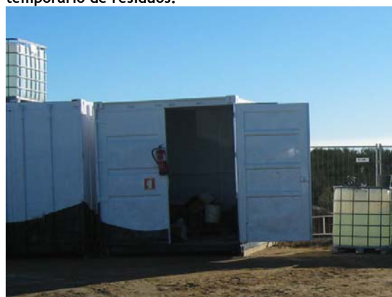
Fotografia 141 - Meios de combate a incêndios na área de estaleiro.
