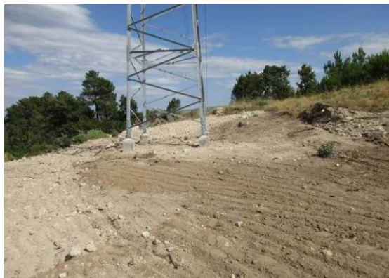
Fotografia 82 - Local de implantação do apoio 45 com a reposição da topografia.
