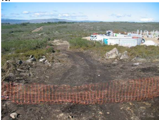
Fotografia 177 - Trilho aberto para o local de implantação do apoio 96.
