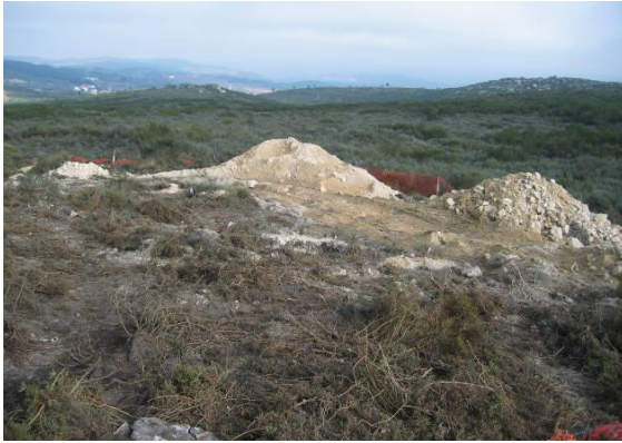
Fotografia 1 - Abertura dos caboucos da fundação do apoio 1.
