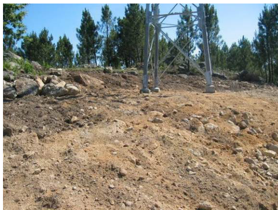
Fotografia 127 - Local de implantação do apoio 67 com a reposição da topografia e solo descompactado.
