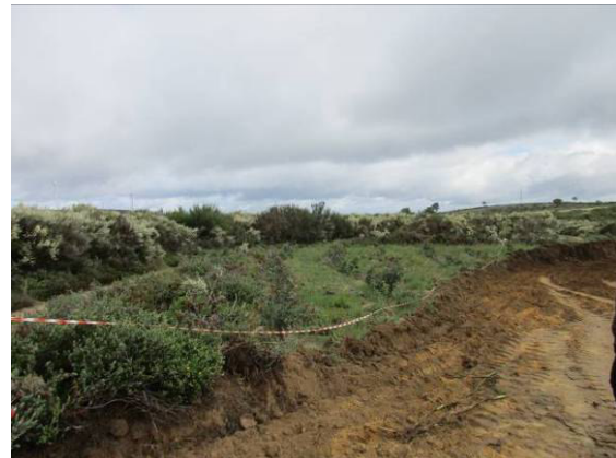
Fotografia 104 - Balizagem da via L9, entre os aerogeradores AG30 e AG31.
