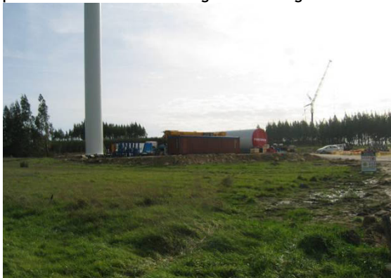
Fotografia 162 - Equipamentos afetos aos trabalhos de montagem na plataforma do aerogerador AG06.
