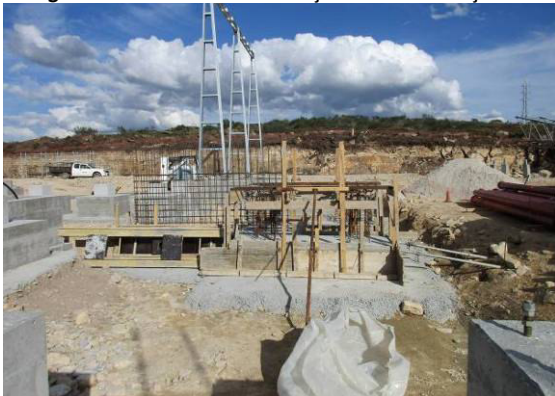
Fotografia 5 - Trabalhos de construção da subestação.
