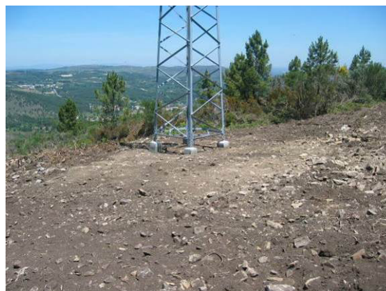
Fotografia 153 - Local de implantação do apoio 82 com reposição da topografia.
