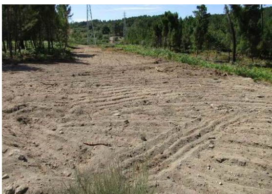
Fotografia 101 - Acesso ao apoio 54-A descompactado.
