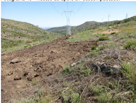
Fotografia 41 - Área de implantação do apoio 22 após a reposição das condições iniciais.
