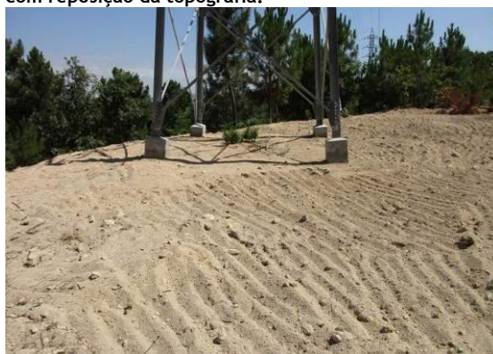
Fotografia 104 - Local de implantação do apoio 55 descompactado.
