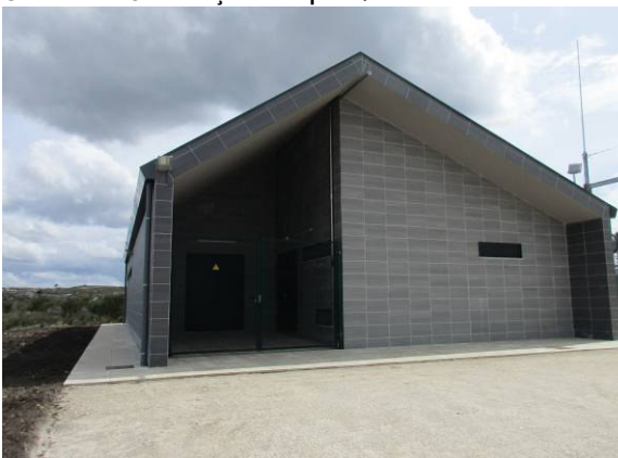
Fotografia 38 - Edifício de Comando.
