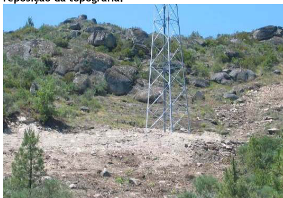
Fotografia 163 - Local de implantação do apoio 88 com reposição da topografia.
