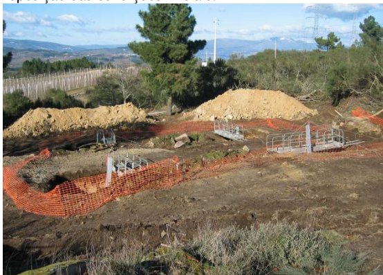
Fotografia 82 - Montagem das bases da fundação do apoio 47.
