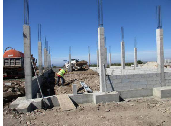
Fotografia 37 - Construção do Edifício de Comando.
