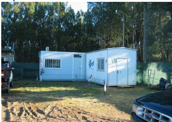
Fotografia 188 - Contentores de escritórios na área social do estaleiro de Armamar.
