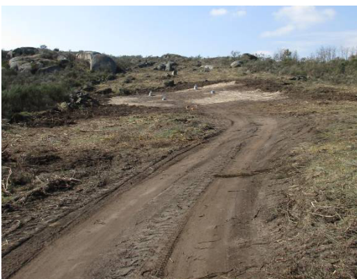
Fotografia 7 - Fundação do apoio 4 aterrada.
