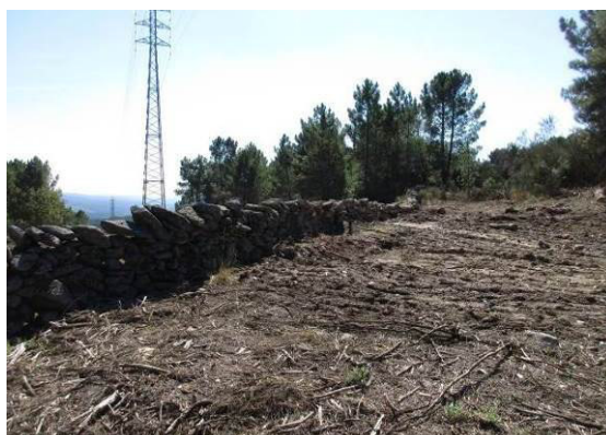
Fotografia 40 - Acesso ao apoio 19 descompactado e muros de pedra seca reconstruídos.
