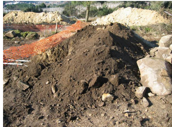
Fotografia 104 - Tera vegetal proveniente da decapagem da área de intervenção do apoio 47 armazenada em parga.
