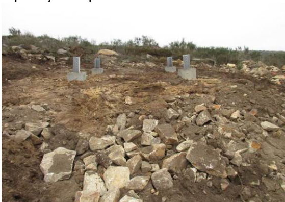
Fotografia 179 - Fundação do apoio 96 aterrada.
