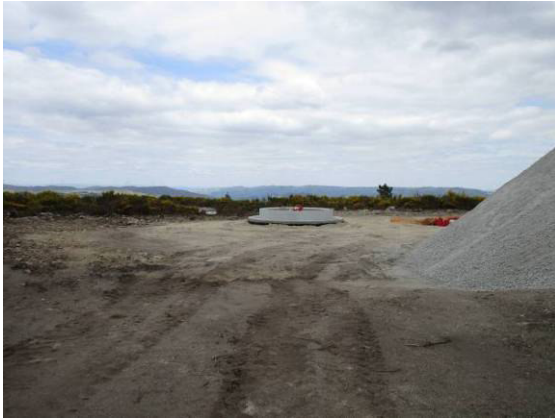
Fotografia 51 - Fundação do aerogerador AG24 aterrada.
