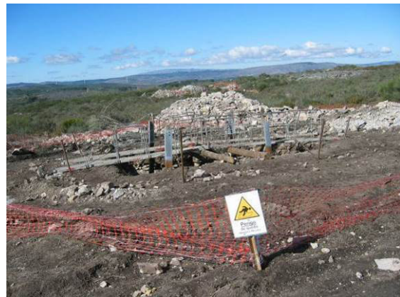
Fotografia 173 - Bases montadas na fundação do apoio 94.
