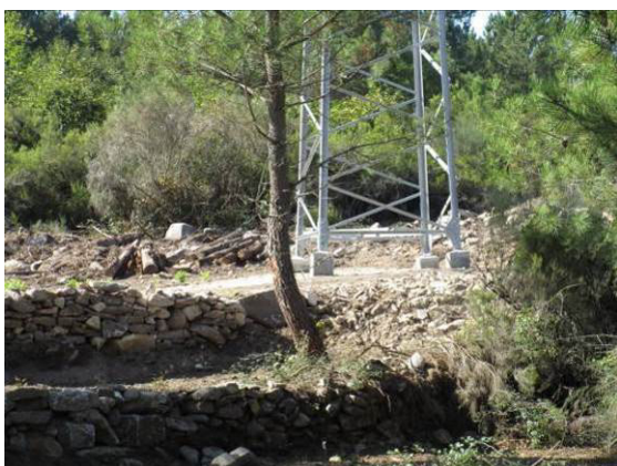
Fotografia 51 - Local de implantação do apoio 27 com reposição da topografia.
