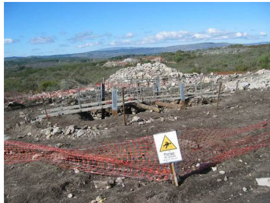
Fotografia 199 - Balizagem da área de intervenção do apoio 94.
