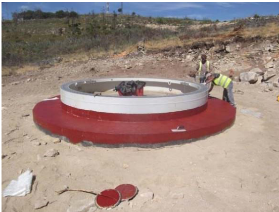
Fotografia 87 - Trabalhos de impermeabilização da fundação do aerogerador AG38.
