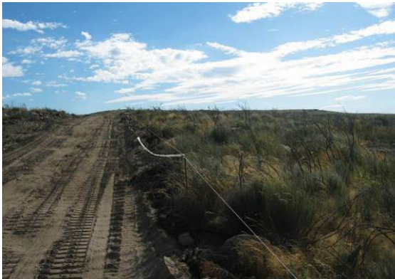
Fotografia 58 - Área de intervenção da beneficiação do acesso entre os aerogeradores AG07 e AG08 balizada.
