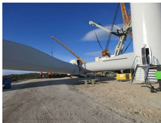
Fotografia 29 - Trabalhos de montagem das pás do aerogerador AG10.
