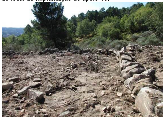
Fotografia 36 - Acesso ao apoio 17 descompactado e muro de pedra seca reconstruído.
