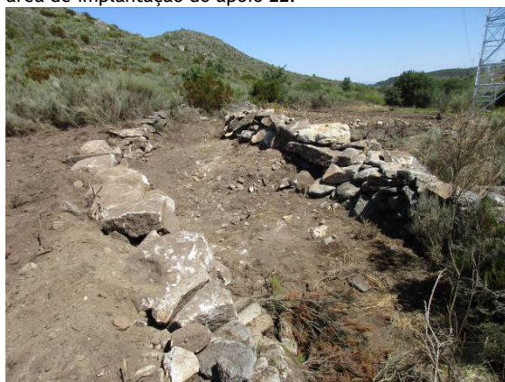
Fotografia 44 - Muros de pedra seca reconstruídos junto da área de implantação do apoio 23.
