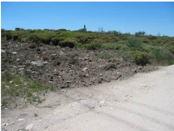
Fotografia 172 - Acesso ao apoio 93 descompactado.
