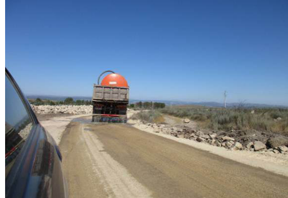
Fotografia 57 - Veículo que efetua a rega dos acessos para controlo da emissão de poeiras em obra.
