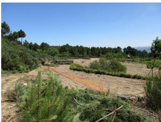
Fotografia 92 - Área de implantação da plataforma do aerogerador AG40 balizada.
