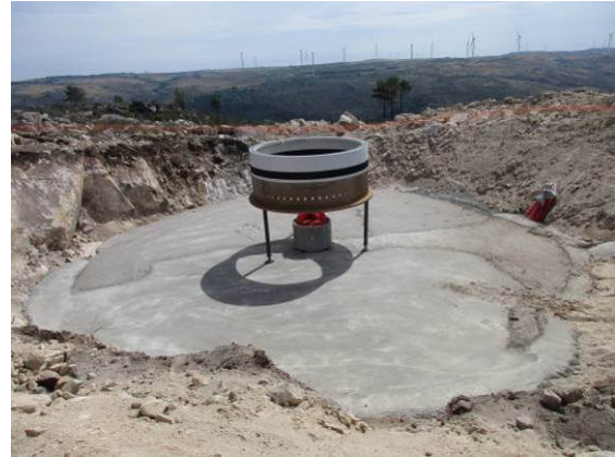
Fotografia 23 - Fundação do aerogerador AG08 com betão de limpeza e anel de fundação.
