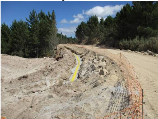
Fotografia 127 - Vala de cabos entre os aerogeradores AG37 e AG38.
