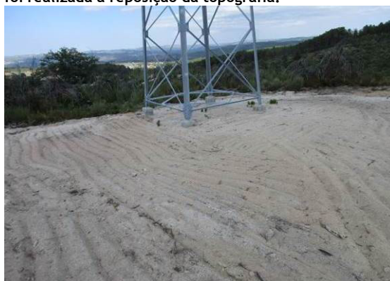
Fotografia 80 - Local de implantação do apoio 44 com a reposição da topografia.
