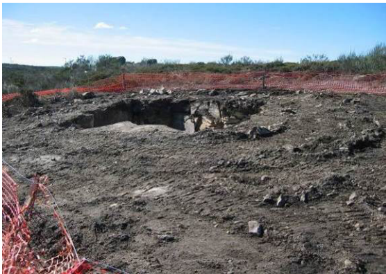
Fotografia 170 - Cabouco da fundação do apoio 93 aberto.
