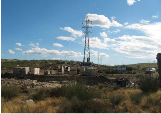
Fotografia 1 - Trabalhos de desenrolamento dos cabos no apoio 1.
