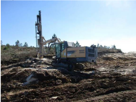
Fotografia 1 - Furacão para a colocação de explosivos na área de implantação do aerogerador AG01.
