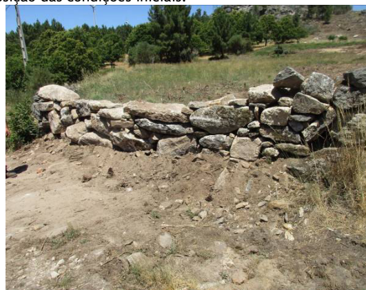
Fotografia 64 - Muro de pedra reconstruído no início do acesso ao apoio 36.
