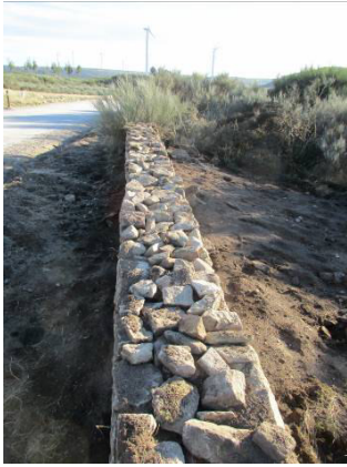
Fotografia 154 - Muro de pedra seca reconstruído na proximidade do aerogerador AG19.
