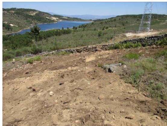
Fotografia 49 - Acesso ao apoio 26 descompactado e muro de pedra seca reconstruído.
