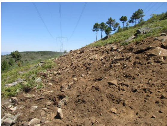
Fotografia 49 - Acesso ao apoio 26 descompactado e muro de pedra seca reconstruído.
