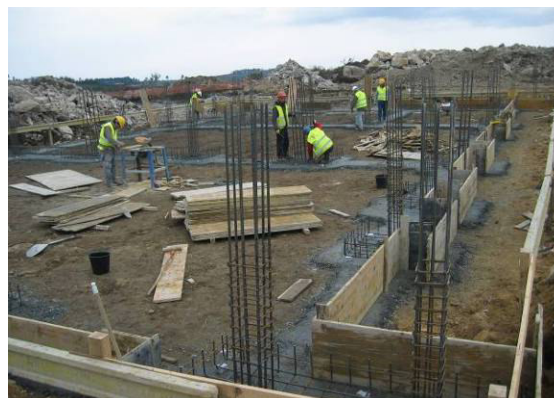
Fotografia 24 - Execução das fundações do Edifício de Comando.
