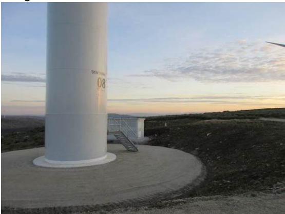
Fotografia 24 - Área de implantação do aerogerador AG08 após a implementação das medidas de recuperação paisagística.
