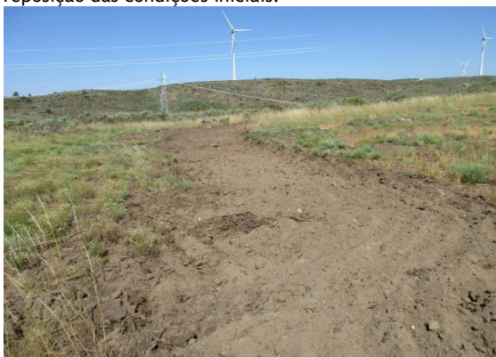
Fotografia 40 - Acesso ao apoio 21 descompactado.
