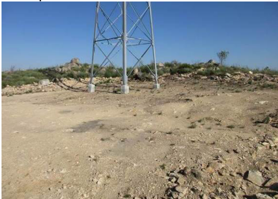
Fotografia 59 - Local de implantação do apoio 31 com reposição da topografia.
