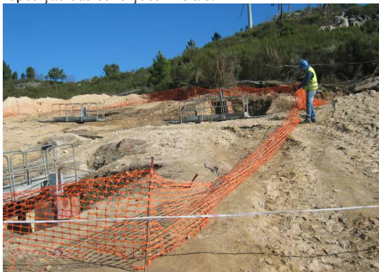
Fotografia 76 - Montagem das bases da fundação do apoio 44.
