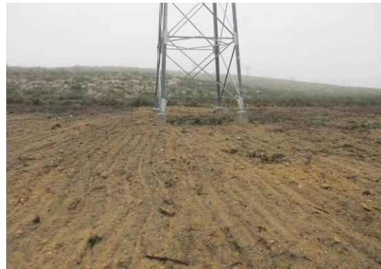
Fotografia 4 - Local de implantação do apoio 1B com a reposição da topografia.
