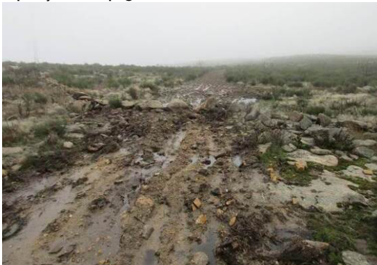
Fotografia 5 - Muro de pedra seca reconstruído no acesso ao apoio 1B.
