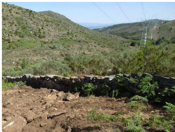
Fotografia 42 - Muro de pedra seca reconstruído junto da área de implantação do apoio 22.
