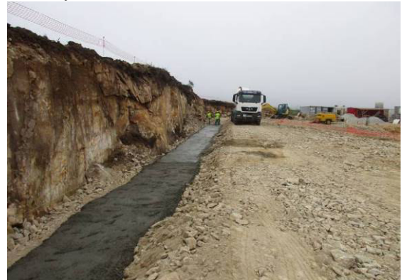
Fotografia 4 - Betonagem do muro vedação.
