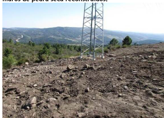
Fotografia 44 - Local de implantação do apoio 22 com reposição da topografia e descompactação do solo.
