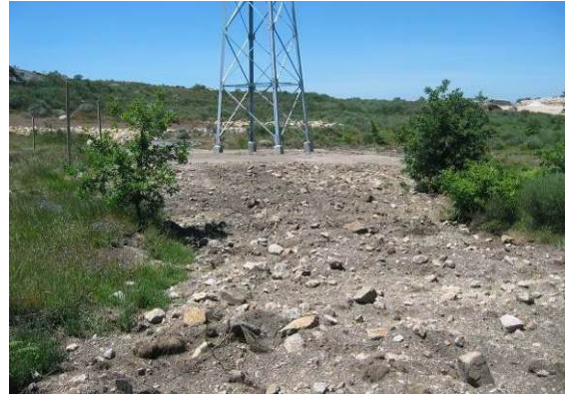
Fotografia 169 - Local de implantação do apoio 92 com reposição da topografia e acesso descompactado.
