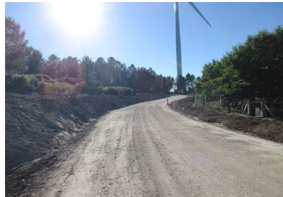
Fotografia 48 - Acesso do parque eólico (via C) sem qualquer material impermeabilizante.
