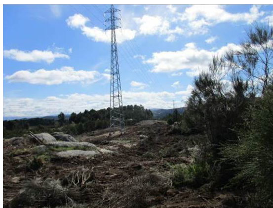
Fotografia 78 - Local de implantação do apoio 42 onde foi realizada a reposição da topografia.
