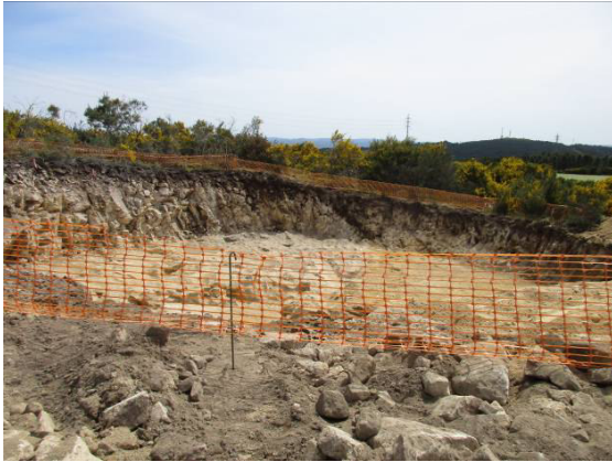
Fotografia 71 - Cabouco da fundação do aerogerador AG32.
