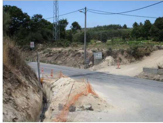
Fotografia 126 - Vala de cabos junto à estrada municipal de Carapito.
