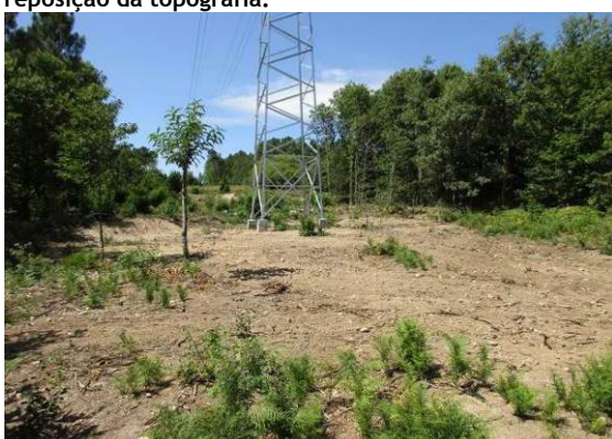
Fotografia 109 - Local de implantação do apoio 58 descompactado.
