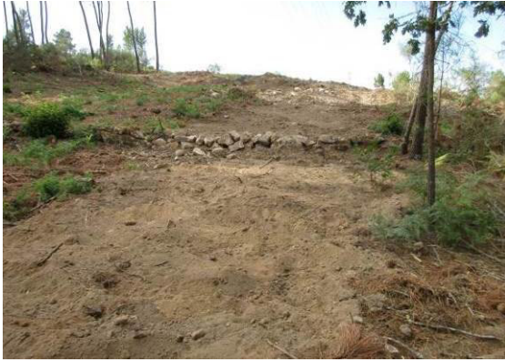
Fotografia 89 - Acesso ao apoio 48 descompactado e muros de pedra seca reconstruídos.
