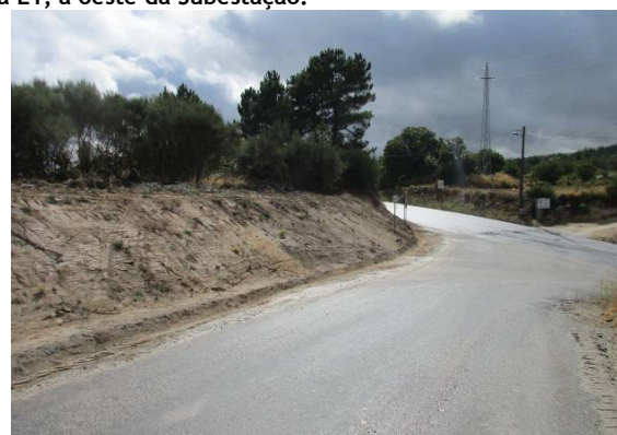
Fotografia 111 - Entrada da via N1.
