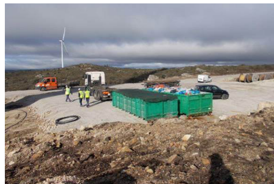
Fotografia 65 - Contentor para o armazenamento temporário de mistura de resíduos de construção e demolição na plataforma do aerogerador AG10 (apoio para a fase de montagem dos aerogeradores).
