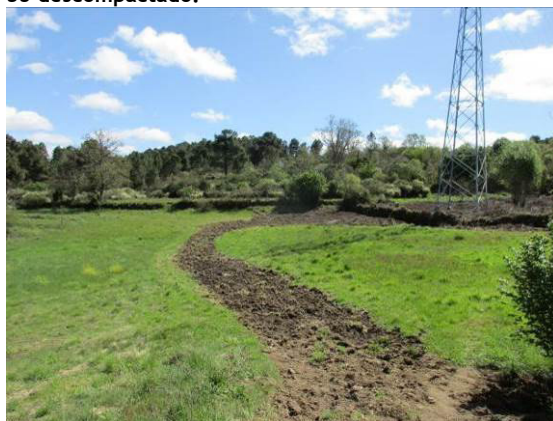
Fotografia 68 - Solo descompactado no acesso ao local de implantação do apoio 36.
