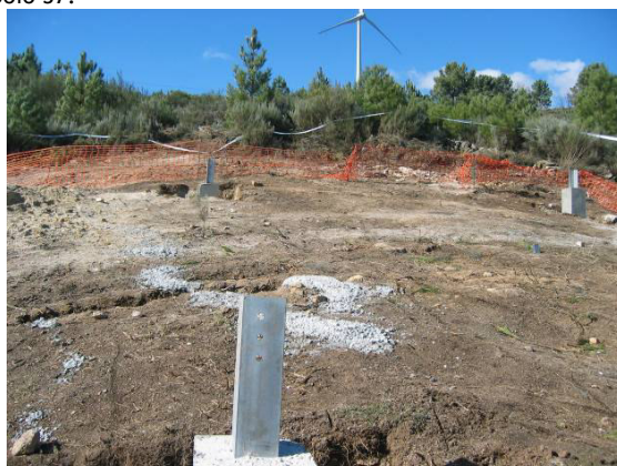
Fotografia 67 - Fundação do apoio 38 betonada.
