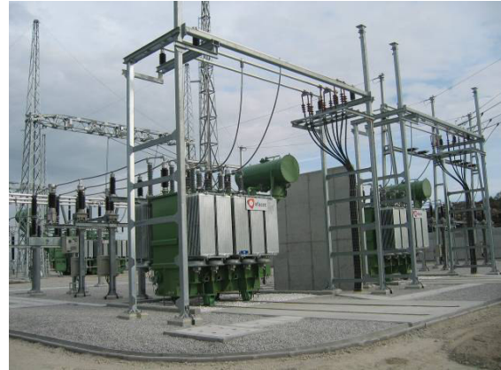
Fotografia 18 - Área de 60 kV com brita e rede de drenagem.
