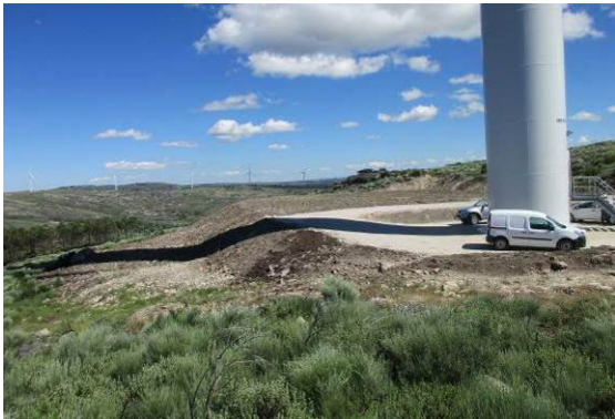
Fotografia 21 - Área de implantação do aerogerador AG07 após a implementação das medidas de recuperação paisagística.
