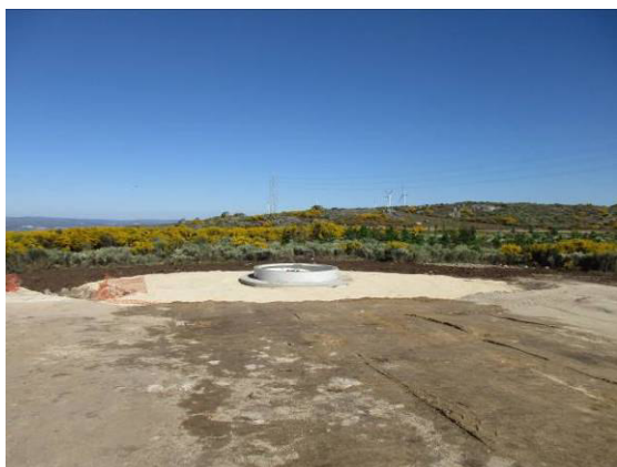
Fotografia 37 - Fundação do aerogerador AG17 aterrada.
