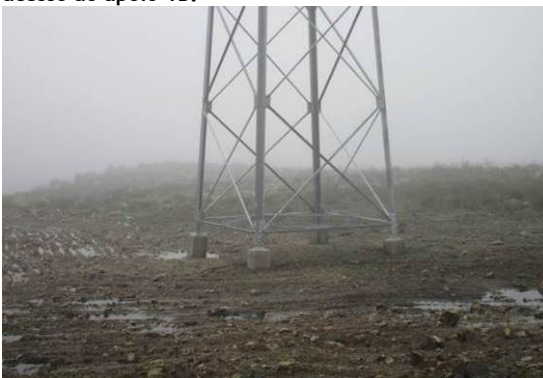
Fotografia 7 - Local de implantação do apoio 1C onde foi realizada a reposição da topografia e descompactação do solo.
