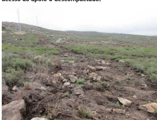
Fotografia 22 - Acesso ao apoio 9 descompactado.
