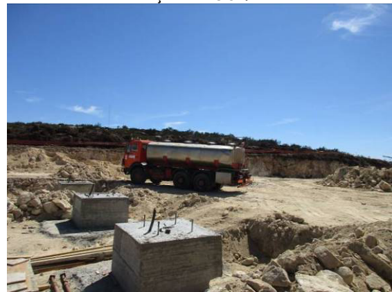
Fotografia 44 - Veículo cisterna para controlo da emissão de poeiras nas áreas de circulação da obra.
