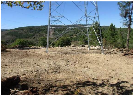
Fotografia 33 - Local de implantação do apoio 16 com a reposição da topografia.
