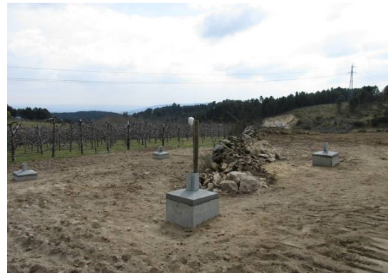
Fotografia 29 - Fundação do apoio 15 aterrada.
