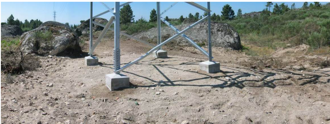
Fotografia 128 - Local de implantação do apoio 68.
