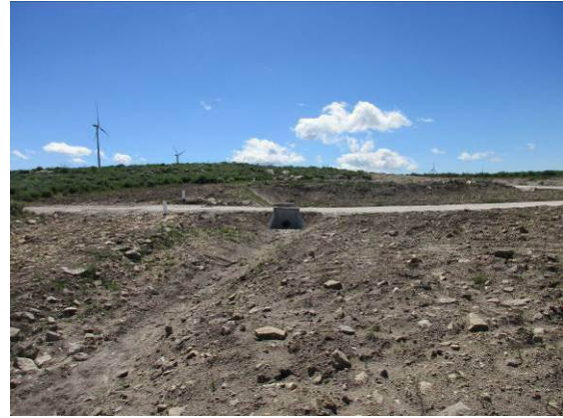
Fotografia 50 - Passagem hidráulica no acesso ao aerogerador AG08.
