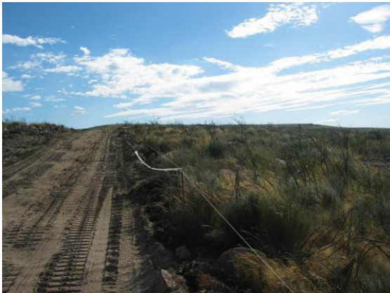
Fotografia 40 - Acesso existente entre os aerogeradores AG07 e AG08 antes da intervenção.
