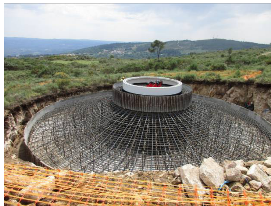
Fotografia 77 - Armação de ferro da fundação do aerogerador AG34.
