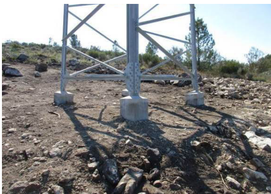
Fotografia 49 - Local de implantação do apoio 25.
