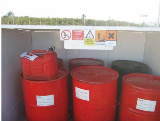
Fotografia 137 - Bacias de retenção para armazenamento temporário de substâncias perigosas na área de estaleiro.
