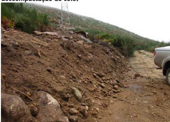
Fotografia 15 - Acesso ao apoio 5 com reposição da topografia e descompactação do solo.
