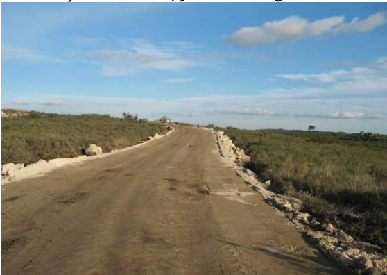
Fotografia 107 - Acesso construído até ao local de implantação do aerogerador AG29 (via L11).
