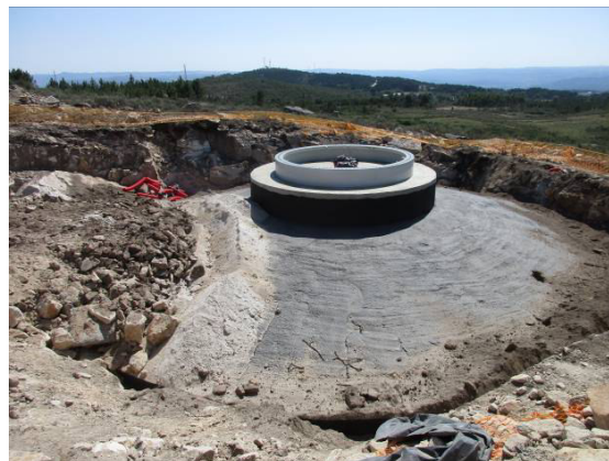
Fotografia 66 - Aterro da fundação do aerogerador AG30.
