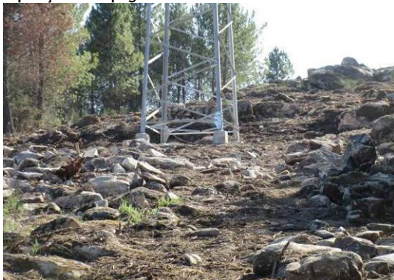
Fotografia 53 - Local de implantação do apoio 28 descompactado.
