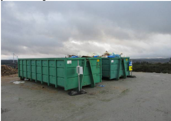
Fotografia 161 - Contentores na plataforma do aerogerador AG04 para o armazenamento temporário de resíduos produzidos durante a montagem dos aerogeradores.
