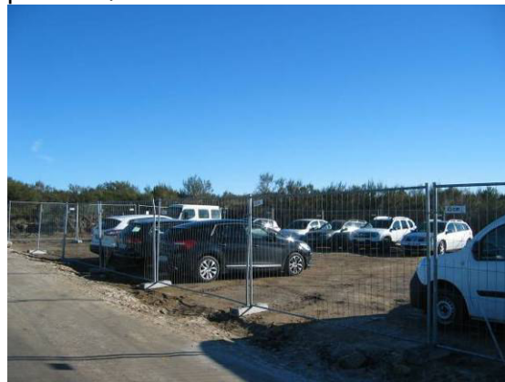
Fotografia 134 - Parque de estacionamento de veículos ligeiros da área de estaleiro.
