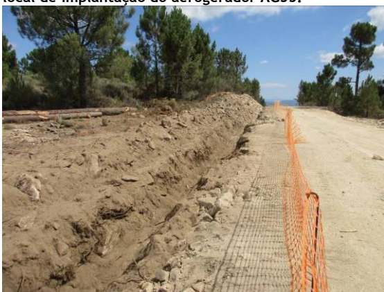
Fotografia 120 - Vala de cabos aberta junto ao aerogerador AG41.
