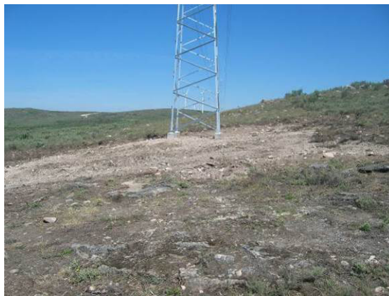
Fotografia 136 - Local de implantação do apoio 71 com reposição da topografia.
