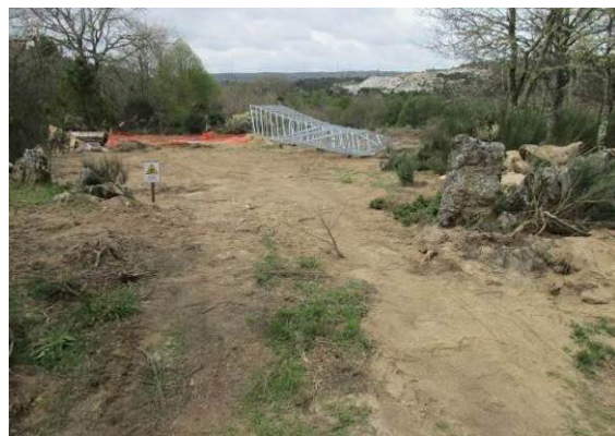
Fotografia 118 - Local de implantação do apoio 63 com o apoio assemblado.
