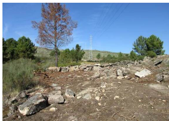
Fotografia 56 - Acesso ao apoio 29 descompactado e muro de pedra seca reconstruído.
