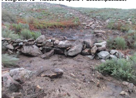
Fotografia 20 - Muro de pedra seca reconstruído e acesso ao apoio 8 descompactado.
