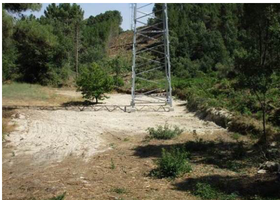
Fotografia 97 - Local de implantação do apoio 53 descompactado.
