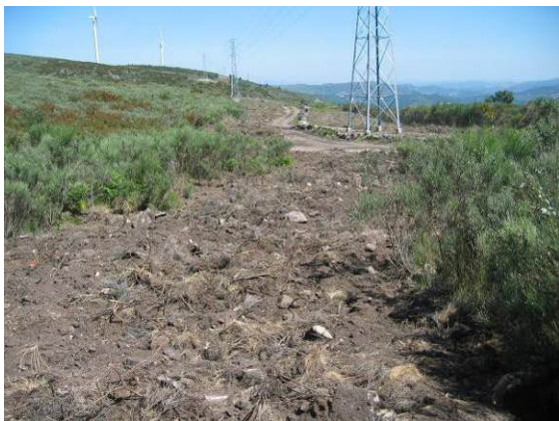
Fotografia 142 - Acesso ao apoio 75 descompactado.
