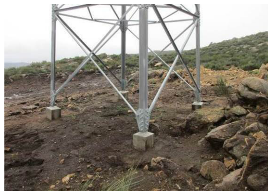
Fotografia 16 - Local de implantação do apoio 6.
