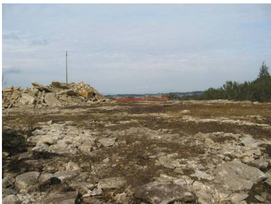
Fotografia 24 - Construção da plataforma do aerogerador AG11.
