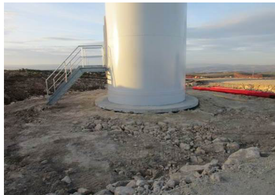
Fotografia 14 - Torre do aerogerador AG05 montada.
