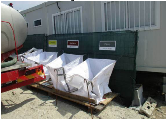
Fotografia 62 - Parque de resíduos na área de estaleiro.
