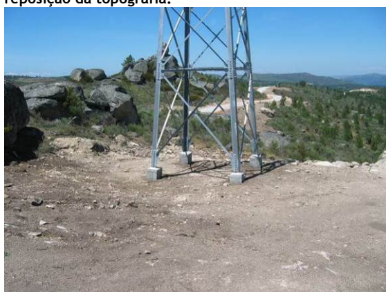
Fotografia 165 - Local de implantação do apoio 89 com reposição da topografia.
