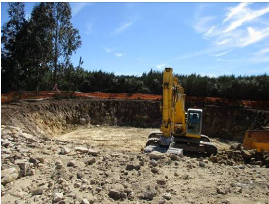
Fotografia 12 - Escavação da fundação do aerogerador AG06.
