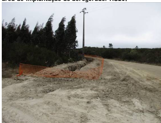
Fotografia 121 - Vala de cabos no início do acesso para o aerogerador AG09.
