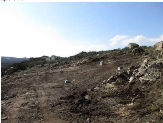
Fotografia 5 - Fundação do apoio 3 aterrada.
