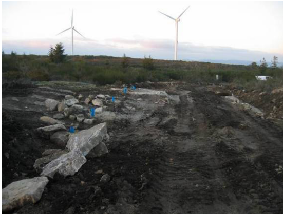
Fotografia 105 - Colocação de explosivos para melhoria da via L8.3, junto do aerogerador AG26.
