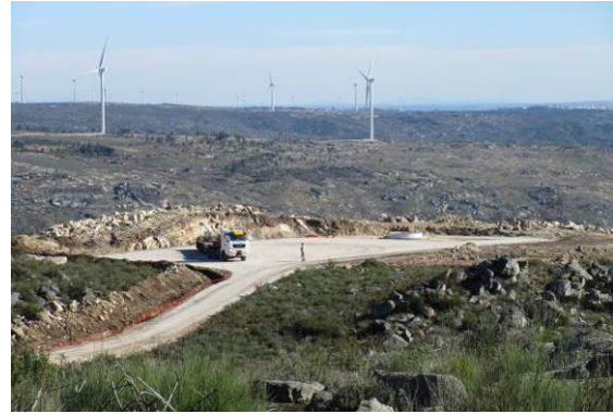
Fotografia 17 - Plataforma do aerogerador AG06 pronta para a fase de montagem do aerogerador.
