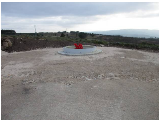
Fotografia 5 - Fundação do aerogerador AG03 aterrada.
