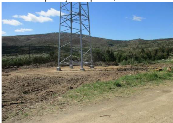
Fotografia 71 - Local de implantação do apoio 38 com solo descompactado.
