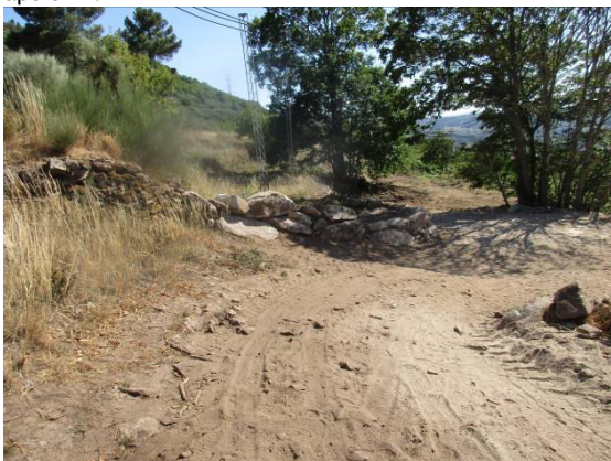
Fotografia 84 - Muro de pedra seca reconstruído junto da área de implantação do apoio 47.
