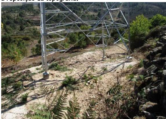
Fotografia 35 - Local de implantação do apoio 17 com a reposição da topografia.
