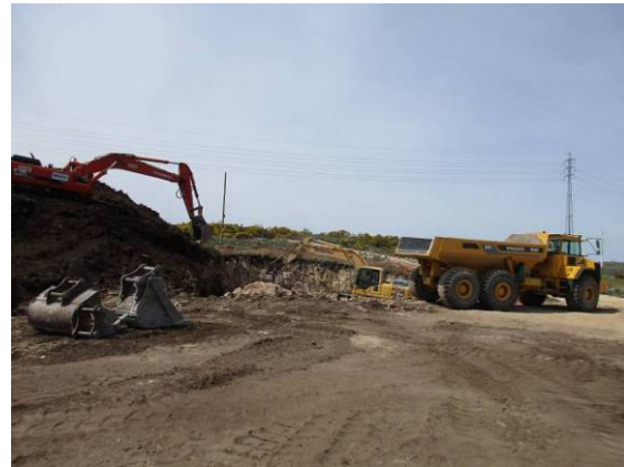
Fotografia 74 - Escavação do cabouco da fundação do aerogerador AG33.
