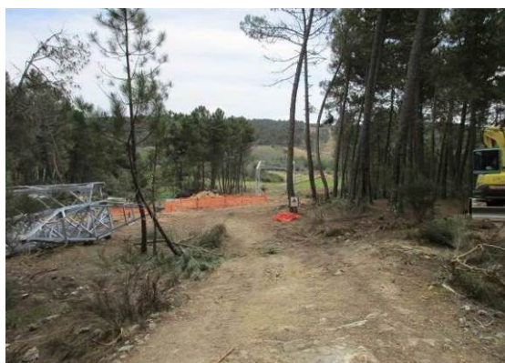
Fotografia 124 - Local de implantação do apoio 65 com o cabouco de fundação aberto e o apoio parcialmente assembled.
