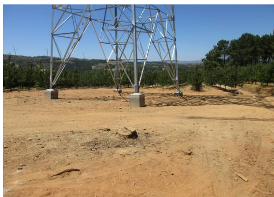
Fotografia 58 - Área de implantação do apoio 32 após a reposição das condições iniciais.
