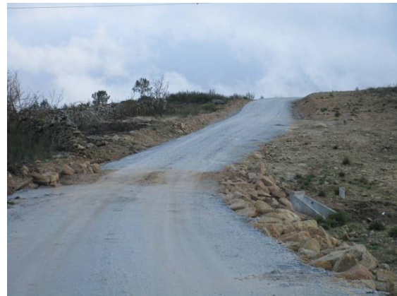
Fotografia 115 - Passagem hidráulica definitiva na via A1, entre os aerogeradores AG01 e AG02.
