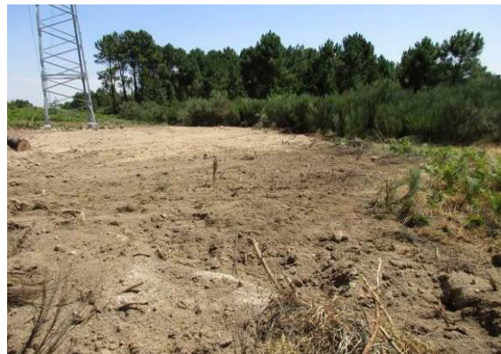
Fotografia 116 - Acesso ao apoio 61 descompactado.
