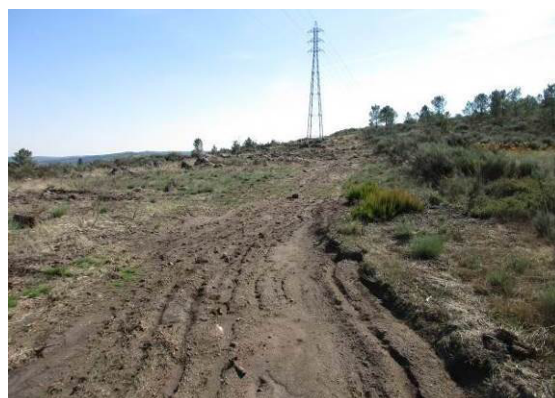
Fotografia 48 - Acesso ao apoio 24 descompactado.
