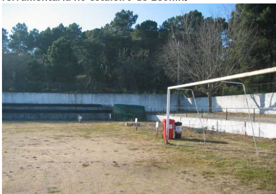
Fotografia 186 - Área destinada ao armazenamento temporário de resíduos de obra.
