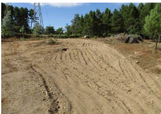
Fotografia 85 - Acesso ao apoio 46 descompactado.
