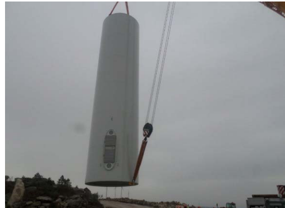
Fotografia 5 - Trabalhos de montagem da torre do aerogerador AG02.
