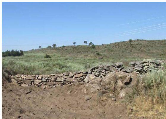
Fotografia 39 - Muro de pedra seca reconstruído no acesso ao apoio 21.
