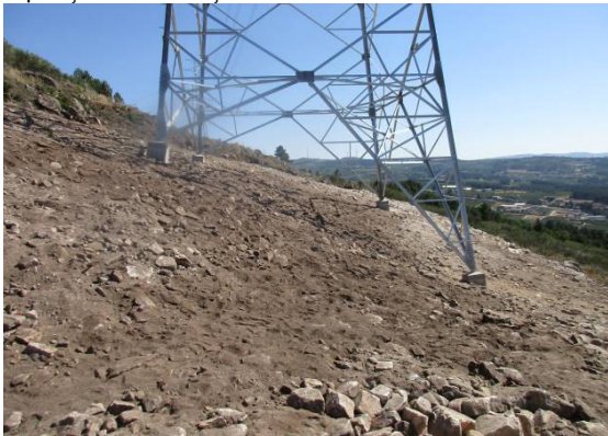
Fotografia 80 - Área de implantação do apoio 46 após reposição das condições iniciais.
