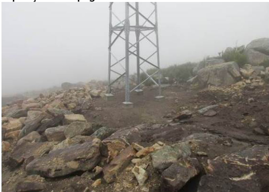
Fotografia 11 - Local de implantação do apoio 3 com reposição da topografia.
