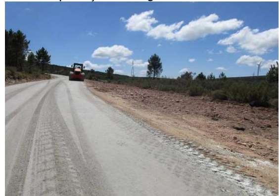
Fotografia 108 - Compactação da camada de tout-venant na via L9, entre os aerogeradores AG34 e AG35.
