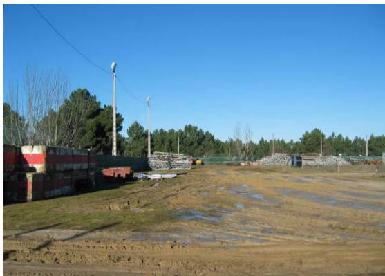
Fotografia 190 - Parque de materiais no estaleiro de Armamar.
