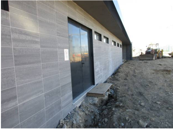
Fotografia 31 - Vista da fachada este do Edifício de Comando.
