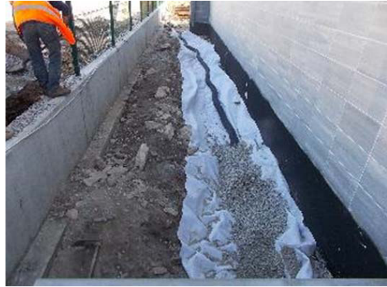
Fotografia 32 - Construção do sistema de drenagem na envolvente do Edifício de Comando.
