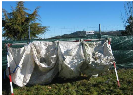
Fotografia 191 - Área para depósito temporário de resíduos no estaleiro de Armamar.
