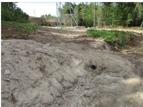
Fotografia 87 - Acesso ao apoio 47 descompactado e vala de drenagem reposta
