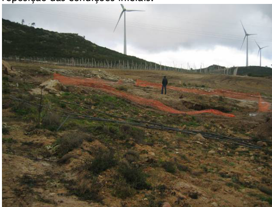
Fotografia 70 - Abertura dos caboucos da fundação do apoio 40.
