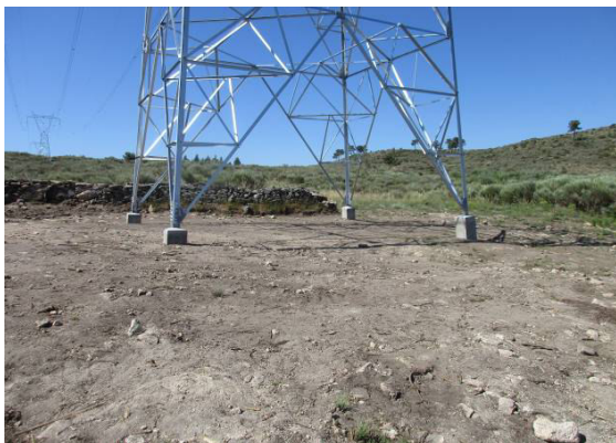
Fotografia 38 - Área de implantação do apoio 21 após a reposição das condições iniciais.
