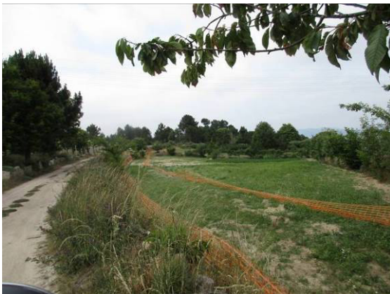
Fotografia 116 - Balizagem contínua da área de intervenção da vala de cabos entre os aerogeradores AG31 e AG37.
