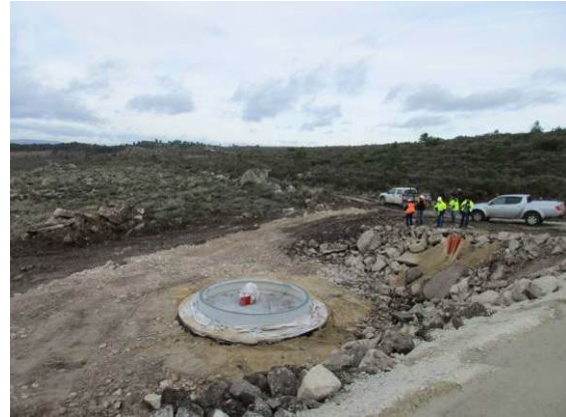
Fotografia 2 - Fundação do aerogerador AG01 já betonada, aterrada e com anel de fundação.
