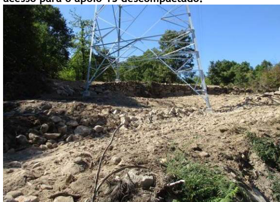
Fotografia 32 - Local de implantação do apoio 15 onde foi realizada a descompactação do solo e modelação do terreno.
