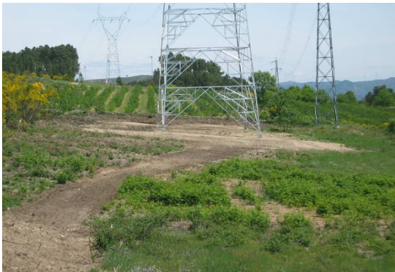
Fotografia 26 - Área de implantação do apoio 13 após a reposição das condições iniciais.
