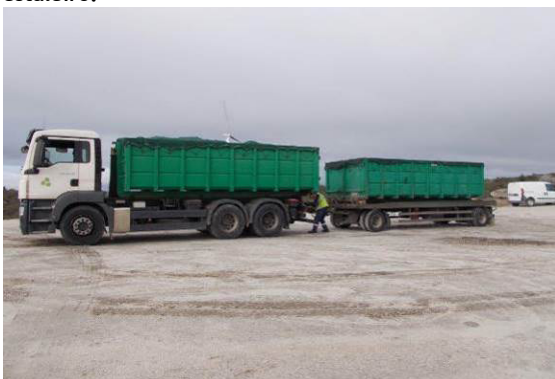
Fotografia 64 - Transporte dos contentores de resíduos para fora da obra.
