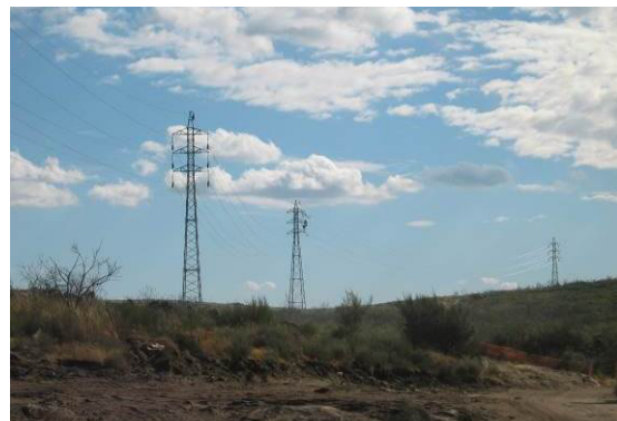
Fotografia 8 - Desenrolamento de cabos entre os apoios 2 a 4.
