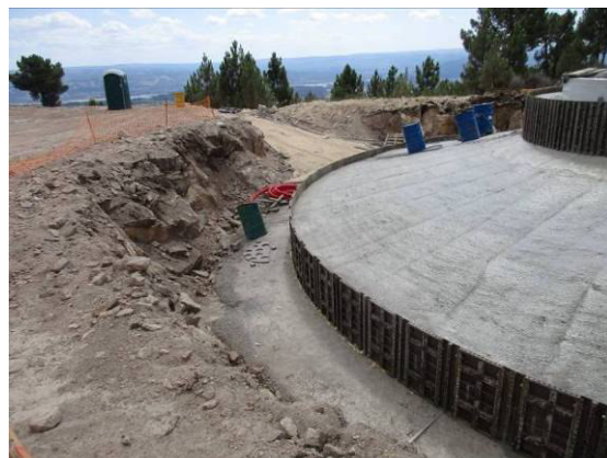
Fotografia 96 - Fundação do aerogerador AG41 betonada.
