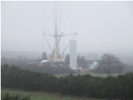
Fotografia 19 - Trabalhos de montagem mecânica do aerogerador AG09.
