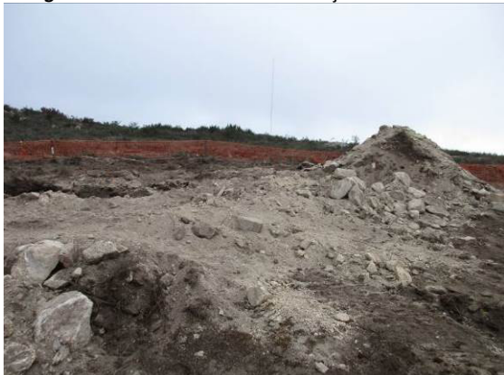
Fotografia 201 - Materiais de escavação do cabouco do apoio 71 armazenados em pargas.
