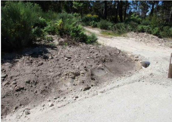
Fotografia 12 - Passagem hidráulica colocada num acesso a um terreno particular por forma a não interromper a valeta do acesso principal (via A).
