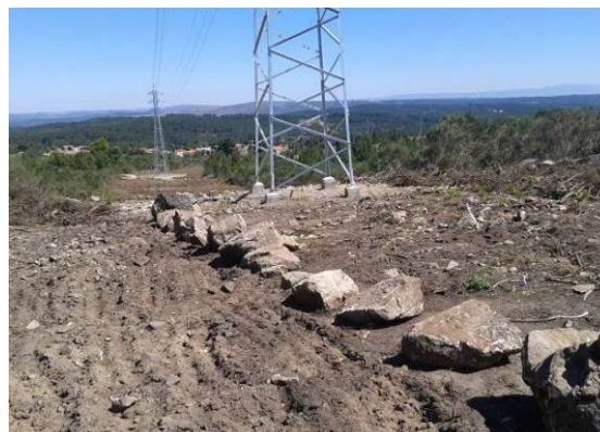
Fotografia 132 - Local de implantação do apoio 70.
