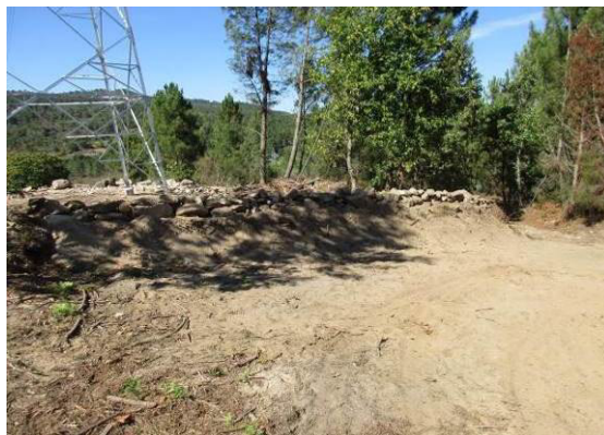
Fotografia 34 - Muro de pedra seca reconstruído junto ao local de implantação do apoio 16.
