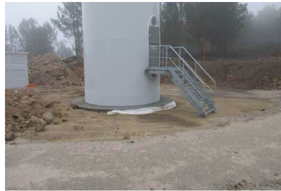
Fotografia 34 - Aerogerador AG12 montado.
