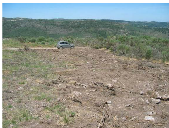
Fotografia 157 - Acesso ao apoio 84 descompactado.
