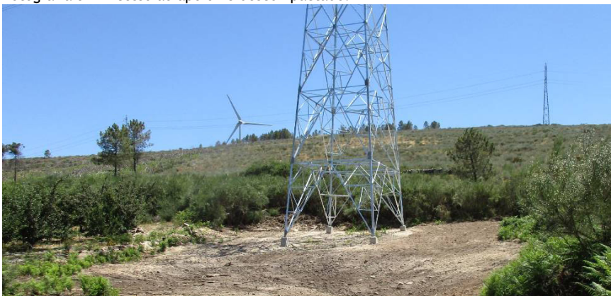
Fotografia 52 - Área de implantação do apoio 28 após a reposição das condições iniciais.
