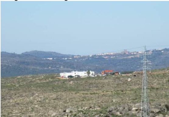
Fotografia 45 - Vista geral da área de estaleiro.
