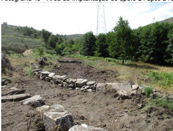
Fotografia 46 - Acesso ao apoio 24 descompactado e muro de pedra seca reconstruído.
