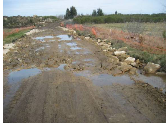
Fotografia 106 - Beneficiação da via L5, de acesso ao local de implantação do aerogerador AG09.
