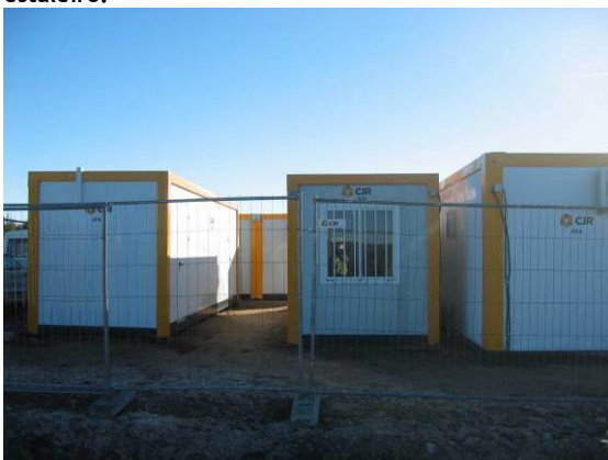
Fotografia 135 - Contentores de escritórios na área social do estaleiro.
