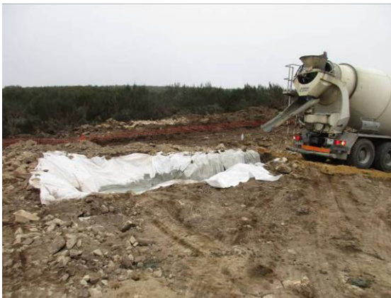
Fotografia 43 - Bacia forrada com geotêxtil para limpeza das caleiras das betoneiras.
