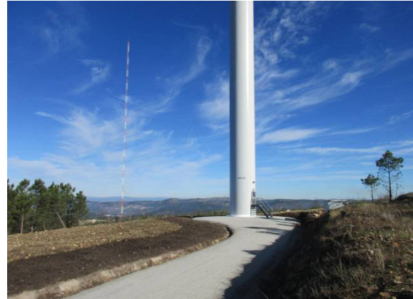
Fotografia 2 - Área de implantação do aerogerador AG01 recuperada.
