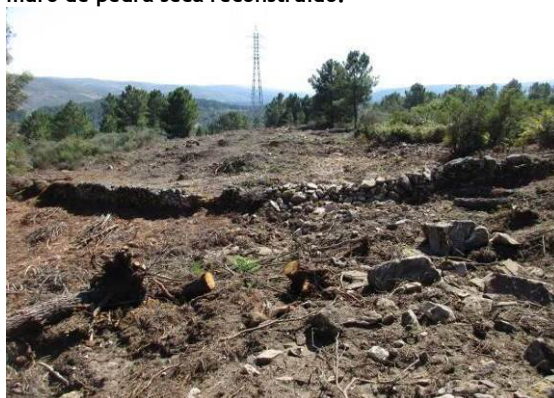
Fotografia 38 - Acesso ao apoio 18 descompactado e muro de pedra seca reconstruído.
