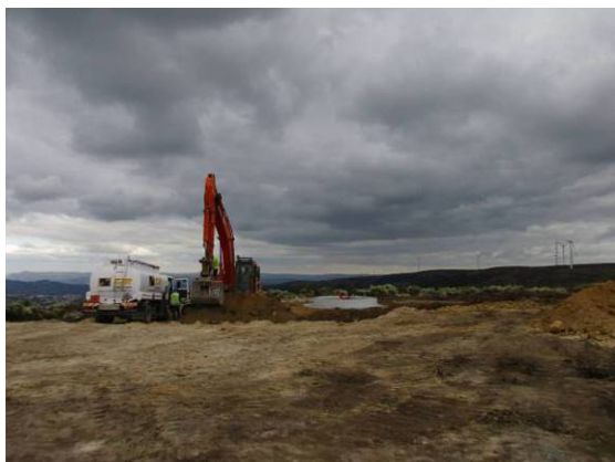
Fotografia 35 - Trabalhos de aterro da fundação do aerogerador AG16.
