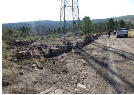
Fotografia 58 - Muro de pedra seca reconstruído junto do local de implantação do apoio 30.
