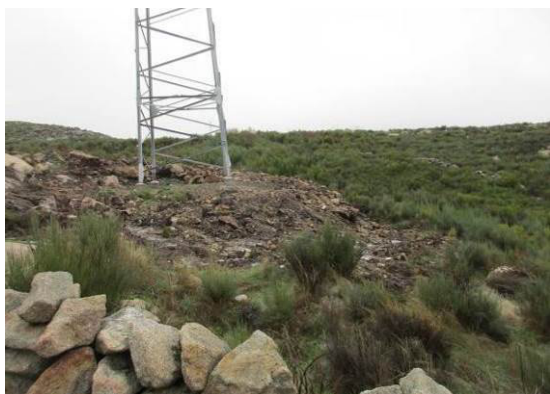
Fotografia 17 - Local de implantação do apoio 7.
