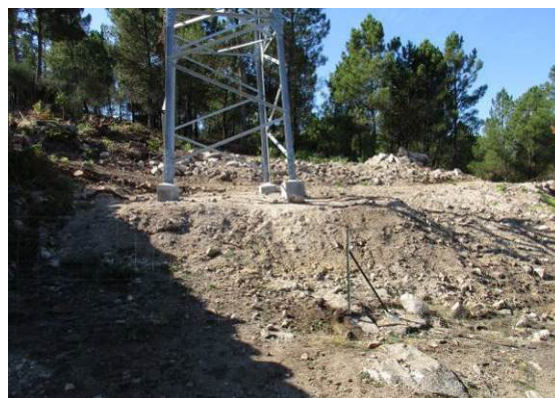
Fotografia 50 - Local de implantação do apoio 26 descompactado.
