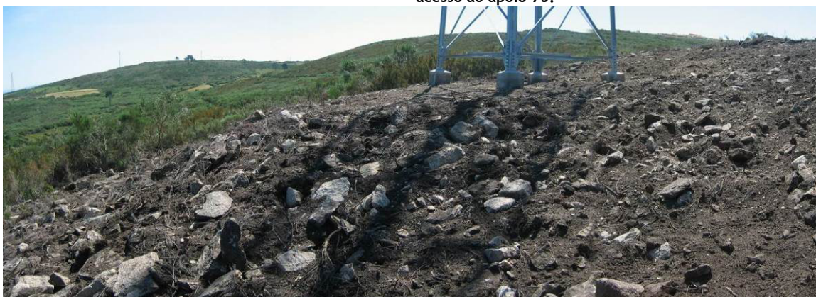
Fotografia 144 - Local de implantação do apoio 76 com reposição da topografia.
