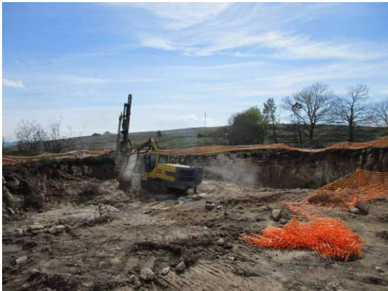
Fotografia 3 - Escavação do cabouco da fundação do aerogerador AG02.
