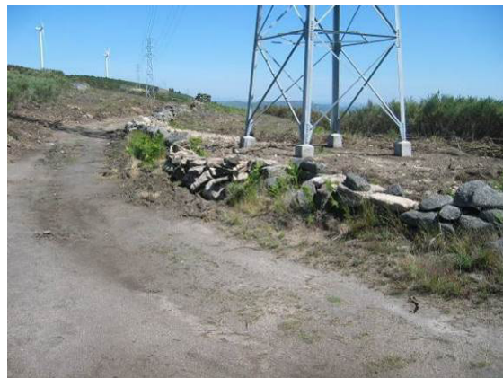
Fotografia 143 - Muro de pedra seca reconstruído no acesso ao apoio 75.
