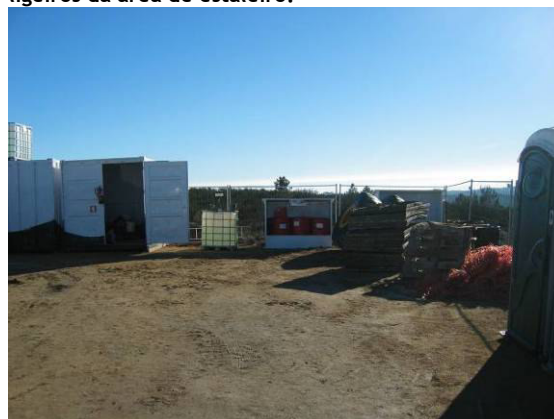
Fotografia 136 - Área de armazenamento de materiais e equipamentos na área de estaleiro.
