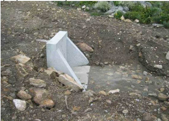
Fotografia 12 - Passagem hidráulica no início do acesso ao aerogerador AG07.
