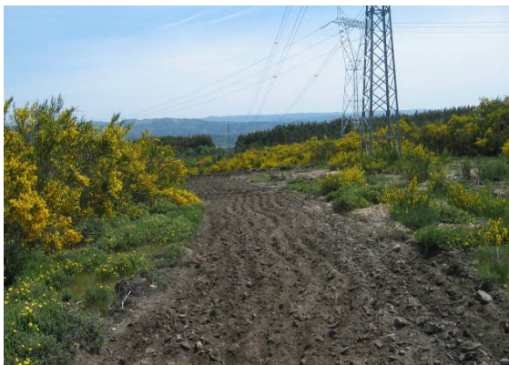
Fotografia 17 - Acesso ao apoio 8 descompactado.
