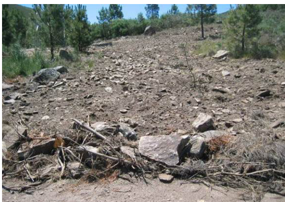
Fotografia 162 - Acesso ao apoio 87 descompactado.
