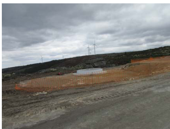
Fotografia 47 - Fundação do aerogerador AG22 aterrada.
