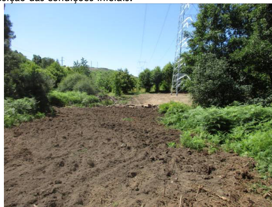
Fotografia 46 - Acesso ao apoio 24 descompactado e muro de pedra seca reconstruído.
