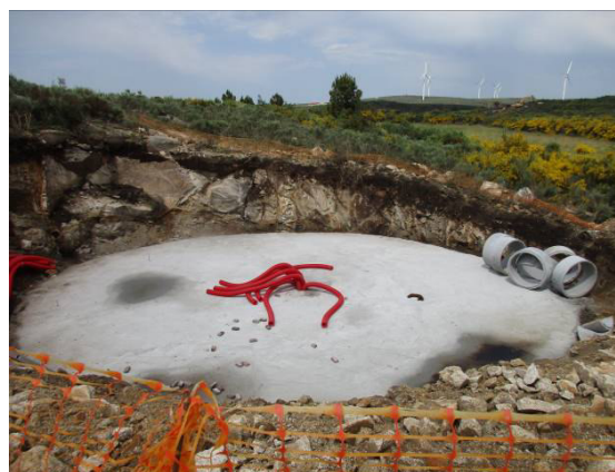
Fotografia 69 - Betão de limpeza na fundação do aerogerador AG31.
