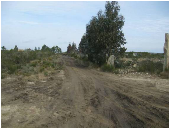
Fotografia 101 - Caminho existente antes da intervenção na área de implantação da via L3, junto ao aerogerador AG11.
