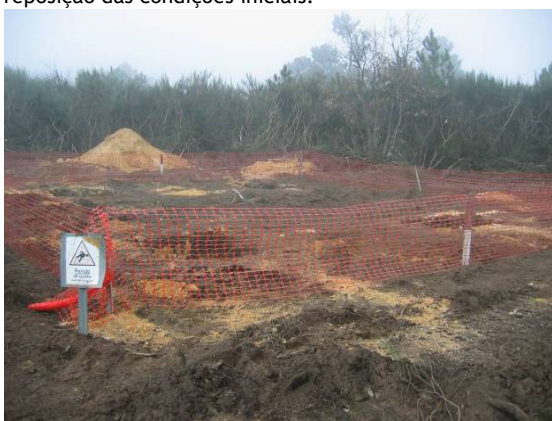
Fotografia 15 - Abertura dos caboucos da fundação do apoio 7.
