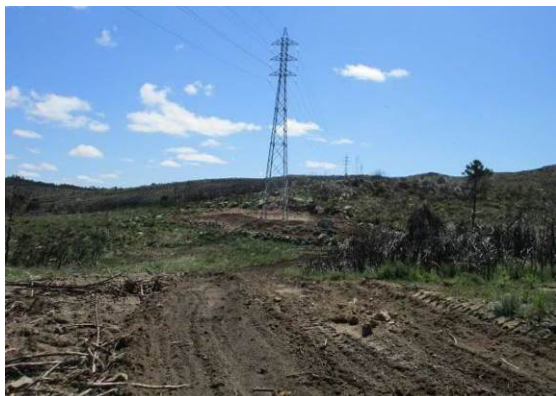
Fotografia 65 - Local de implantação do apoio 34 onde foi realizada a descompactação do solo.
