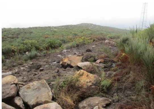
Fotografia 18 - Acesso ao apoio 7 descompactado.
