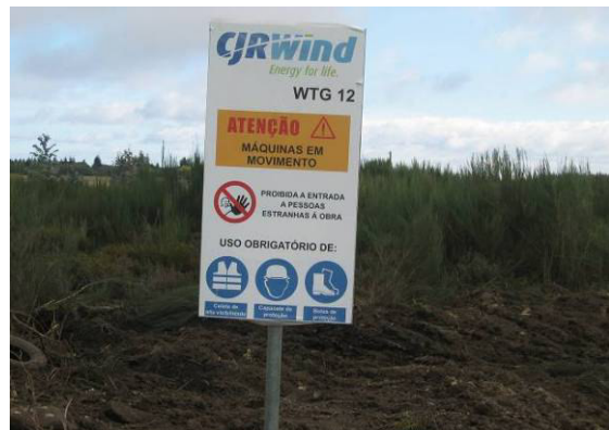
Fotografia 151 - Sinalização de obra à entrada da área de intervenção do aerogerador AG12.
