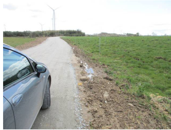
Fotografia 113 - Acesso entre a EM529 e o aerogerador AG06 após a beneficiação realizada.
