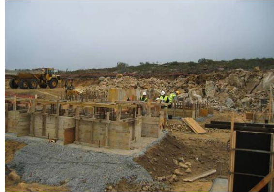
Fotografia 2 - Construção das fundações da Subestação.
