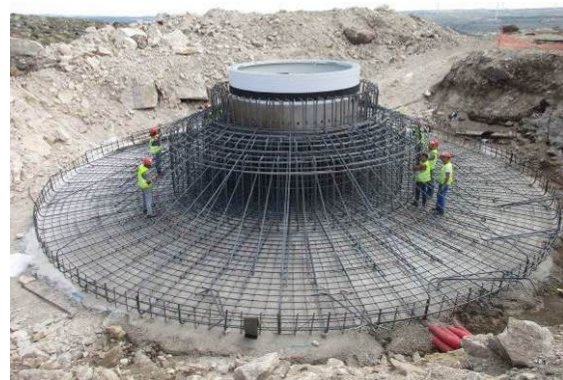
Fotografia 20 - Trabalhos de armação de ferro na sapata do aerogerador AG07.
