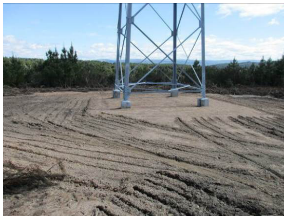
Fotografia 74 - Local de implantação do apoio 40.
