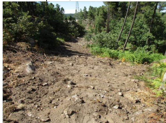
Fotografia 94 - Acesso ao apoio 51 descompactado.
