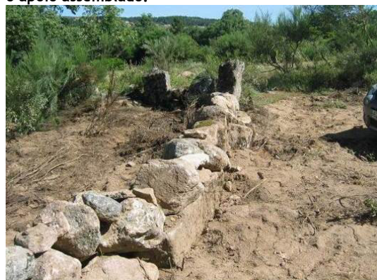
Fotografia 120 - Muro de pedra seca reconstruído junto ao local de implantação do apoio 63.
