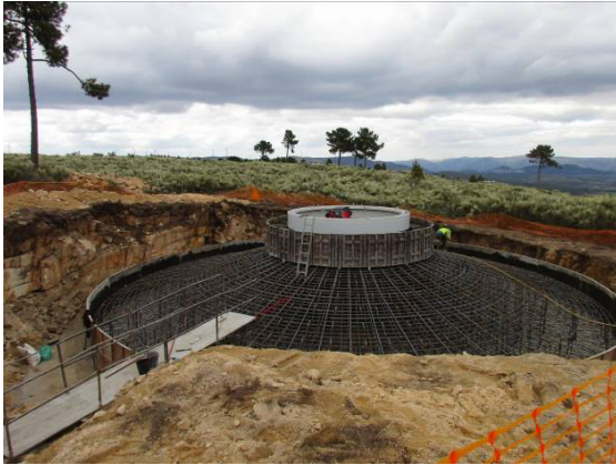
Fotografia 41 - Armação de ferro na fundação do aerogerador AG19.
