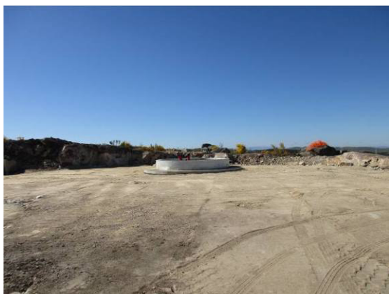
Fotografia 39 - Fundação do aerogerador AG18 aterrada.
