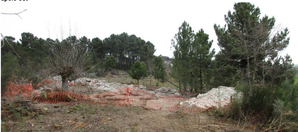
Fotografia 200 - Materiais de escavação do cabouco do apoio 66 armazenados em pargas.
