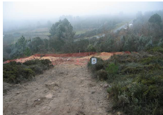
Fotografia 12 - Abertura dos caboucos da fundação do apoio 6.
