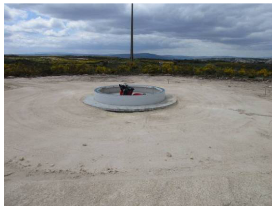
Fotografia 25 - Fundação do aerogerador AG11 aterrada.
