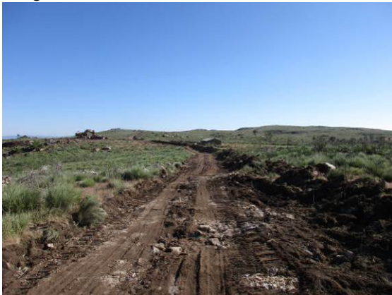
Fotografia 25 - Decapagem do acesso e local de implantação do aerogerador AG09.
