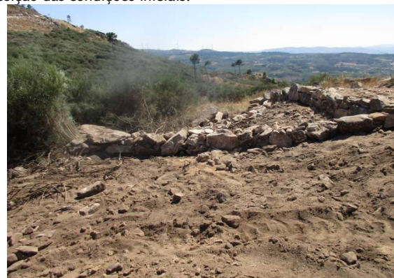
Fotografia 75 - Muros de pedra seca reconstruídos junto da área de implantação do apoio 43.
