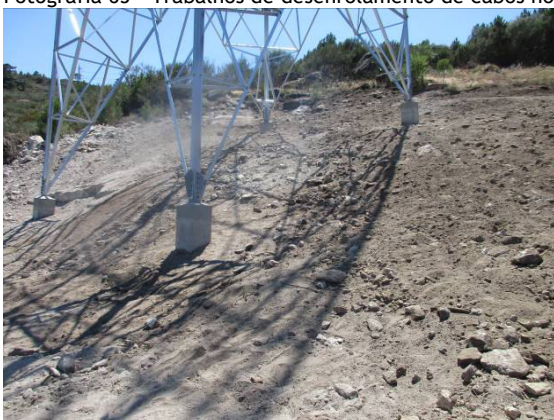
Fotografia 66 - Área de implantação do apoio 37 após a reposição das condições iniciais.
