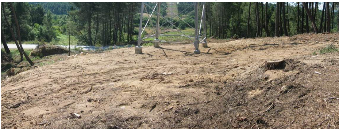
Fotografia 125 - Local de implantação do apoio 65.
