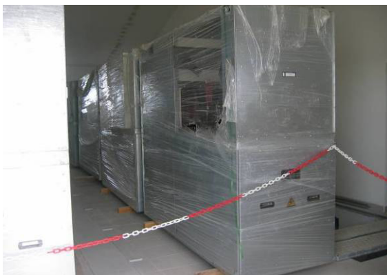
Fotografia 27 - Interior do Edifício de Comando.
