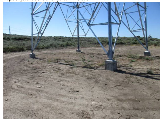
Fotografia 36 - Área de implantação do apoio 19 após a reposição das condições iniciais.
