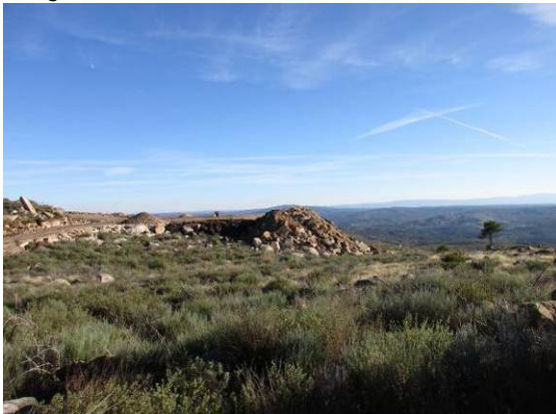
Fotografia 4 - Construção da plataforma do aerogerador AG02.
