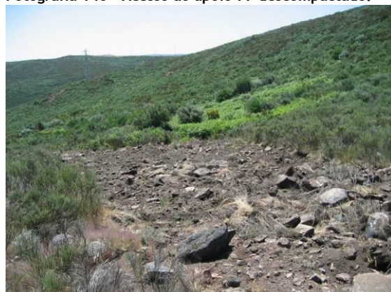
Fotografia 148 - Acesso ao apoio 78 descompactado.
