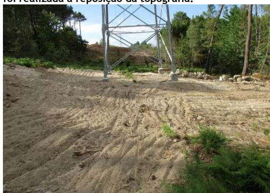
Fotografia 86 - Local de implantação do apoio 47 com reposição da topografia.
