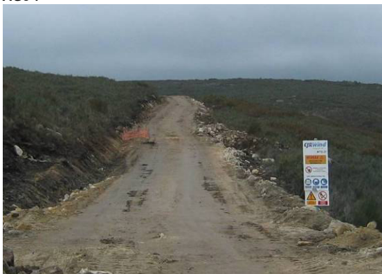
Fotografia 150 - Sinalização de obra na via L10, junto ao aerogerador AG27.
