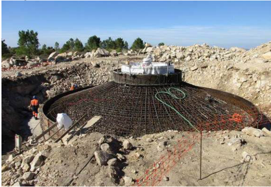
Fotografia 31 - Trabalhos de armação de ferro na fundação do aerogerador AG11.
