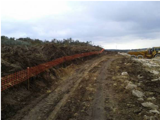
Fotografia 41 - Balizagem da área de intervenção.
