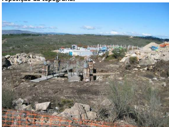
Fotografia 178 - Bases montadas na fundação do apoio 96.
