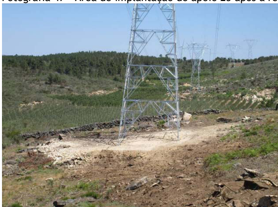
Fotografia 48 - Área de implantação do apoio 26 após a reposição das condições iniciais.
