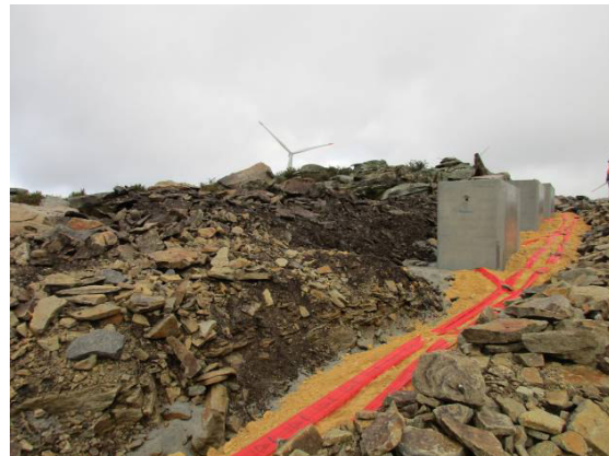
Fotografia 129 - Execução da junção de cabos na vala ao longo da via L8, entre os aerogeradores AG24 e AG25.
