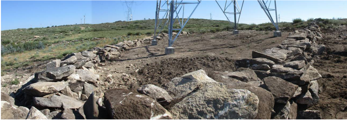
Fotografia 32 - Área de implantação do apoio 16 após a reposição das condições iniciais e muros de pedra seca reconstruídos.
