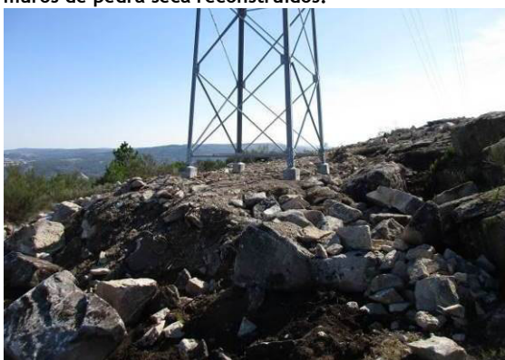
Fotografia 47 - Local de implantação do apoio 24.
