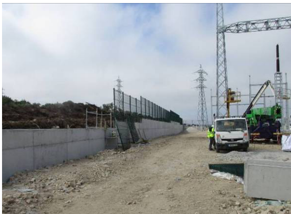
Fotografia 9 - Trabalhos de montagem da vedação.
