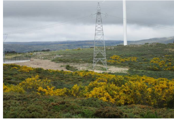
Fotografia 2 - Área de implantação do apoio 1 após a reposição das condições iniciais.
