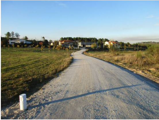
Fotografia 47 - Acesso entre a EM529 e a área de implantação do EC-SE reparada.
