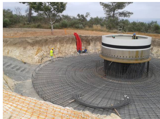
Fotografia 90 - Montagem da armação de ferro da fundação do aerogerador AG39.
