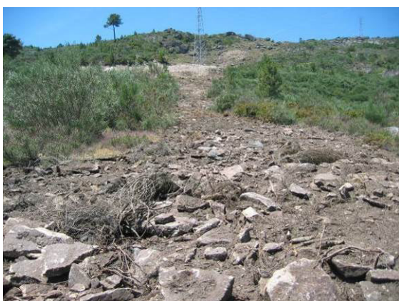
Fotografia 164 - Acesso ao apoio 88 descompactado.
