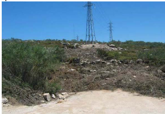
Fotografia 180 - Acesso e local de implantação do apoio 96.
