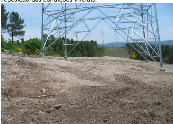
Fotografia 22 - Área de implantação do apoio 11 após a reposição das condições iniciais.
