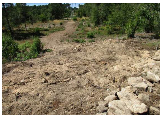
Fotografia 110 - Acesso ao apoio 58 descompactado e muro de pedra seca reconstruído.
