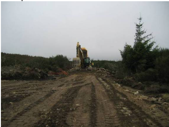
Fotografia 114 - Execução de passagem hidráulica na via L8, junto ao aerogerador AG25.
