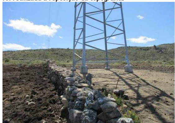
Fotografia 64 - Muro de pedra seca reconstruído junto ao local de implantação do apoio 33.
