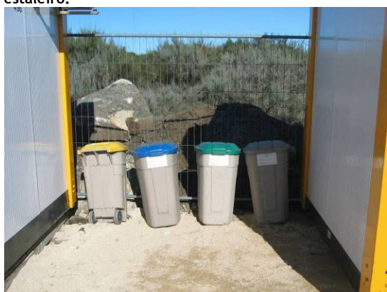
Fotografia 138 - Ecoponto instalado na área social do estaleiro.
