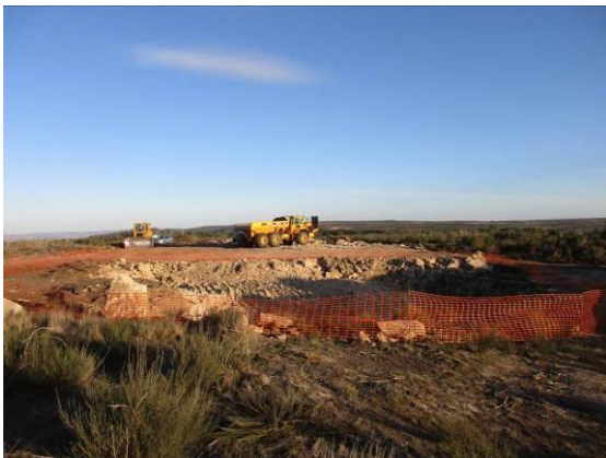
Fotografia 7 - Escavação do cabouco da fundação do aerogerador AG04.
