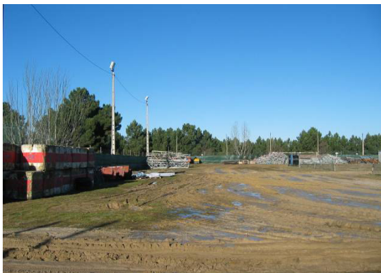
Fotografia 93 - Parque de materiais no estaleiro de Armamar.
