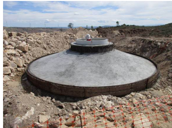
Fotografia 26 - Fundação do aerogerador AG09 betonada.
