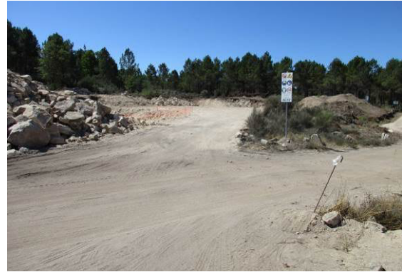
Fotografia 61 - Sinalização da obra.
