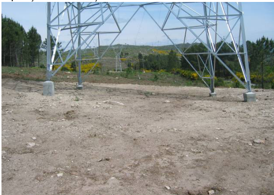
Fotografia 28 - Área de implantação do apoio 14 após a reposição das condições iniciais.
