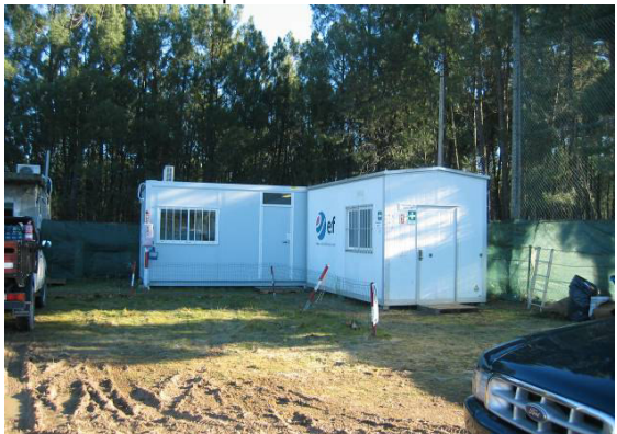
Fotografia 91 - Contentores de escritórios na área social do estaleiro de Armamar.
