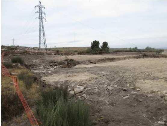
Fotografia 36 - Área de implantação do Edifício de Comando e Subestação decapada.
