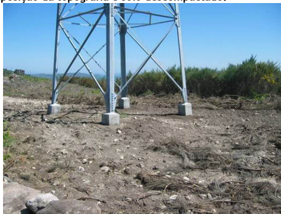
Fotografia 141 - Local de implantação do apoio 75.
