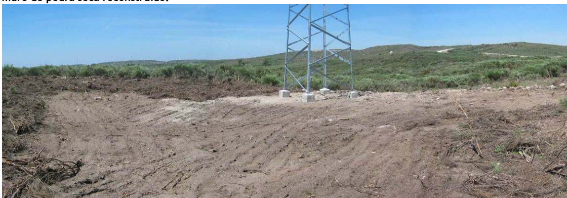
Fotografia 139 - Local de implantação do apoio 73 com reposição da topografia e solo descompactado.
