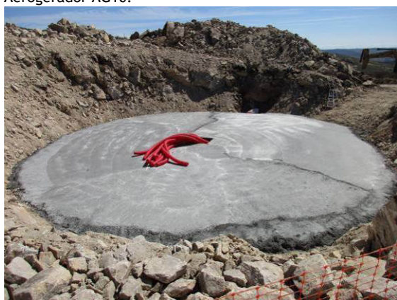
Fotografia 28 - Fundação do aerogerador AG10 com betão de limpeza.
