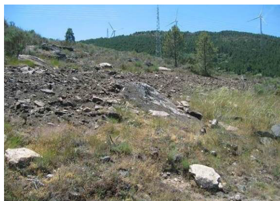
Fotografia 159 - Acesso ao apoio 85 descompactado.
