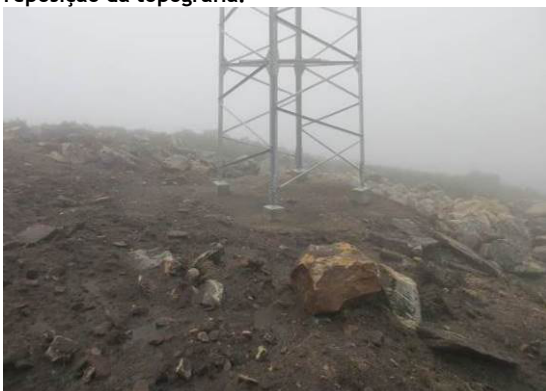
Fotografia 13 - Local de implantação do apoio 4 onde foi realizada a modelação do terreno e descompactação do solo.
