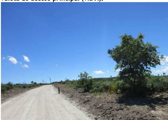
Fotografia 12 - Valeta de drenagem em terreno natural na via A.
