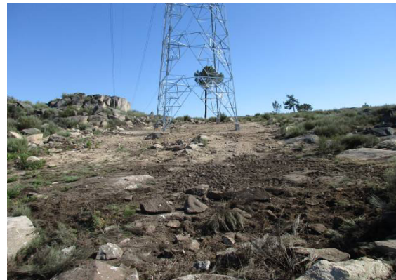
Fotografia 34 - Área de implantação do apoio 18 após a reposição das condições iniciais.
