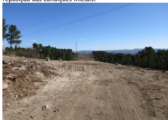
Fotografia 21 - Fundação do apoio 11 aterrada.
