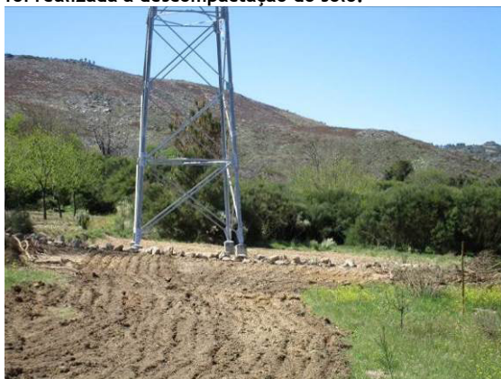
Fotografia 67 - Muro de pedra seca reconstruído junto à área de implantação do apoio 35.
