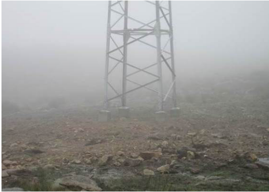
Fotografia 9 - Local de implantação do apoio 2 com a reposição da topografia.
