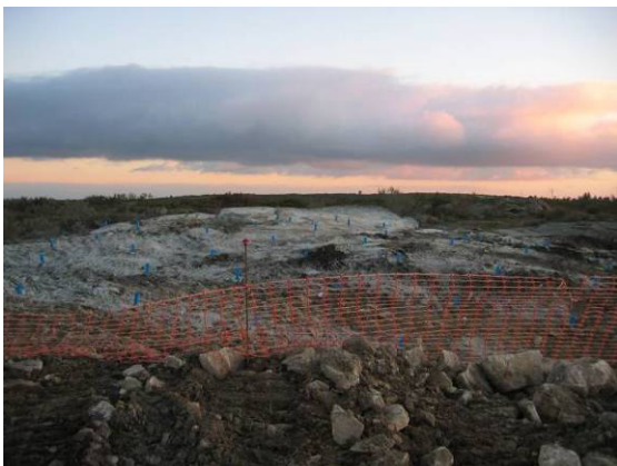
Fotografia 55 - Colocação de explosivos para a escavação do cabouco da fundação do aerogerador AG26.
