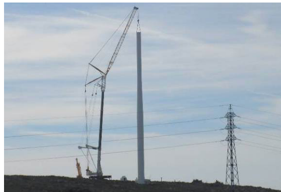
Fotografia 11 - Trabalhos de montagem do aerogerador AG04.
