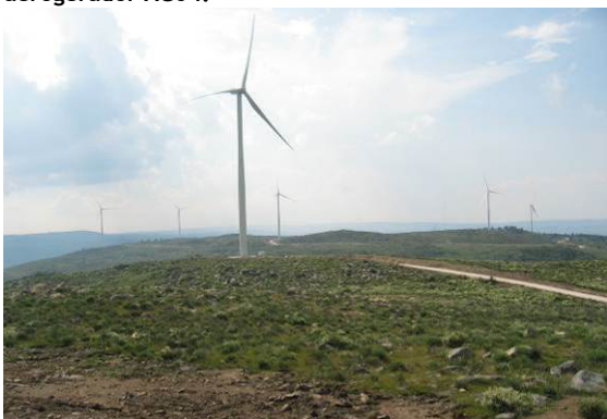
Fotografia 12 - Aerogerador AG04 após a implementação das medidas de recuperação paisagística.
