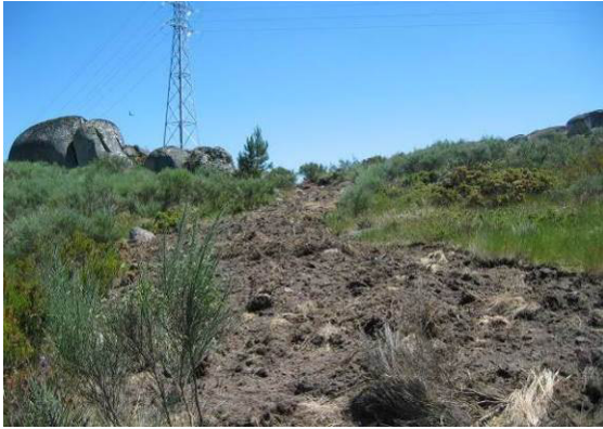
Fotografia 168 - Acesso ao apoio 91 descompactado.
