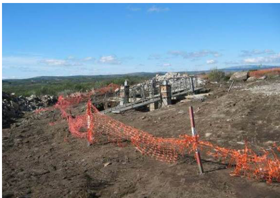
Fotografia 175 - Bases montadas na fundação do apoio 95.
