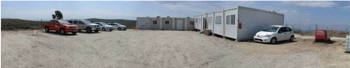
Fotografia 44 - Vista geral da área de estaleiro.
