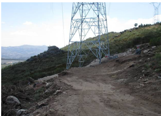
Fotografia 65 - Trabalhos de desenrolamento de cabos no apoio 37.
