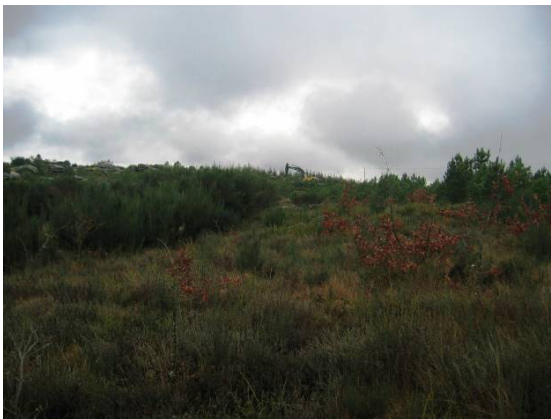
Fotografia 21 - Área de implantação do aerogerador AG10 previamente ao início dos trabalhos.
