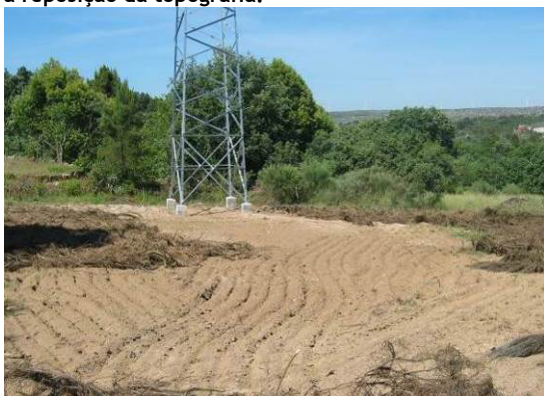
Fotografia 119 - Local de implantação do apoio 63 e acesso descompactado.
