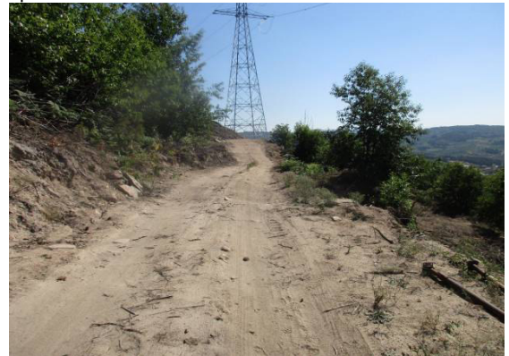
Fotografia 81 - Acesso ao apoio 46 que será mantido.
