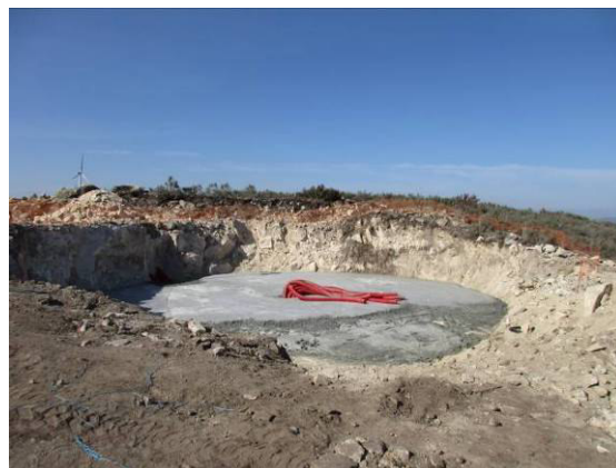
Fotografia 63 - Betão de limpeza na fundação do aerogerador AG29.
