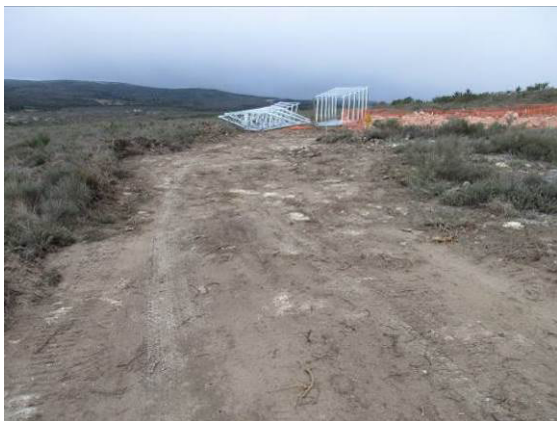
Fotografia 135 - Assemblagem do apoio 71.
